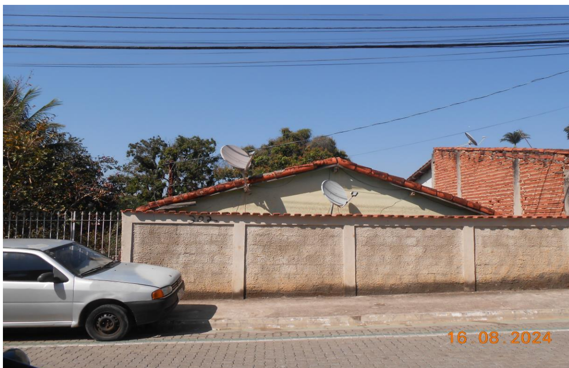
Foto 1: Vista frontal do imóvel de matrícula nº 9.815.
