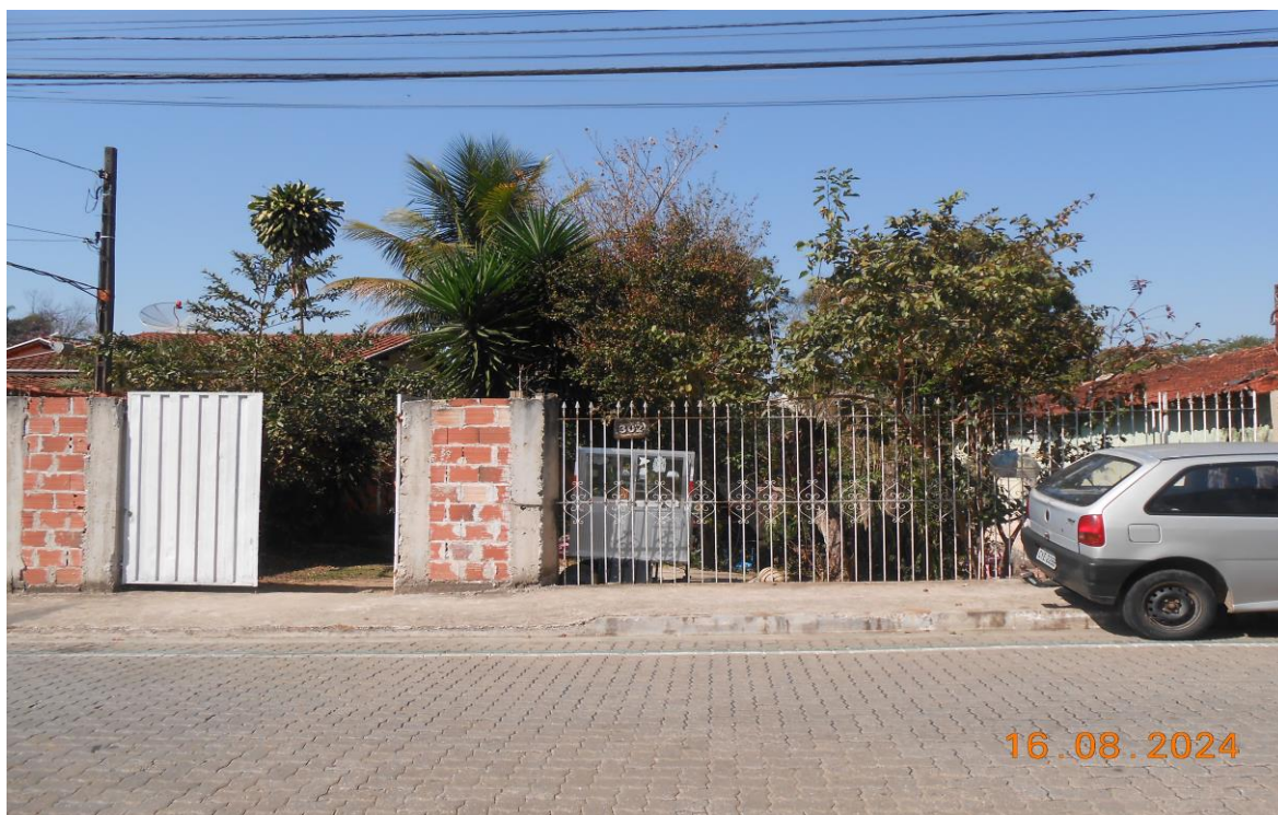
Foto 9: Vista frontal do imóvel de matrícula nº 9.816.
