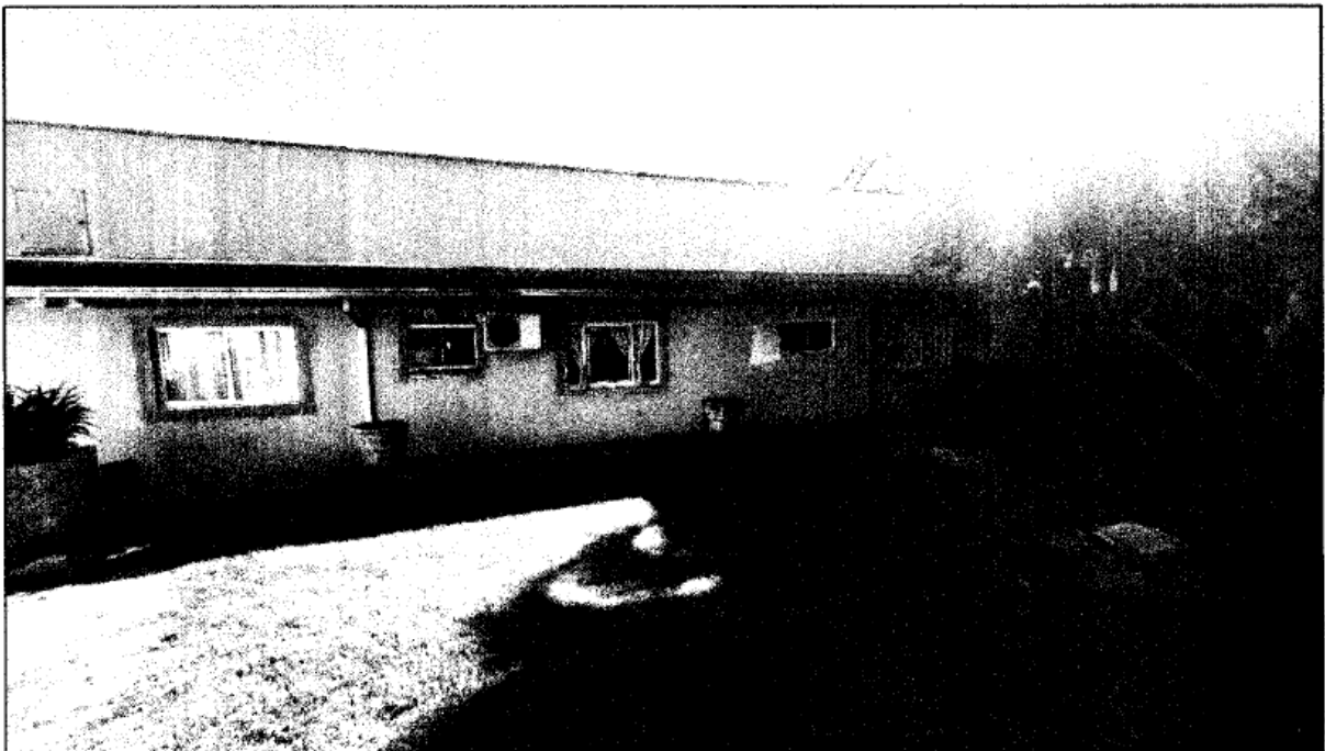
Figura 37 - Fachada de fundos da edificação principal
