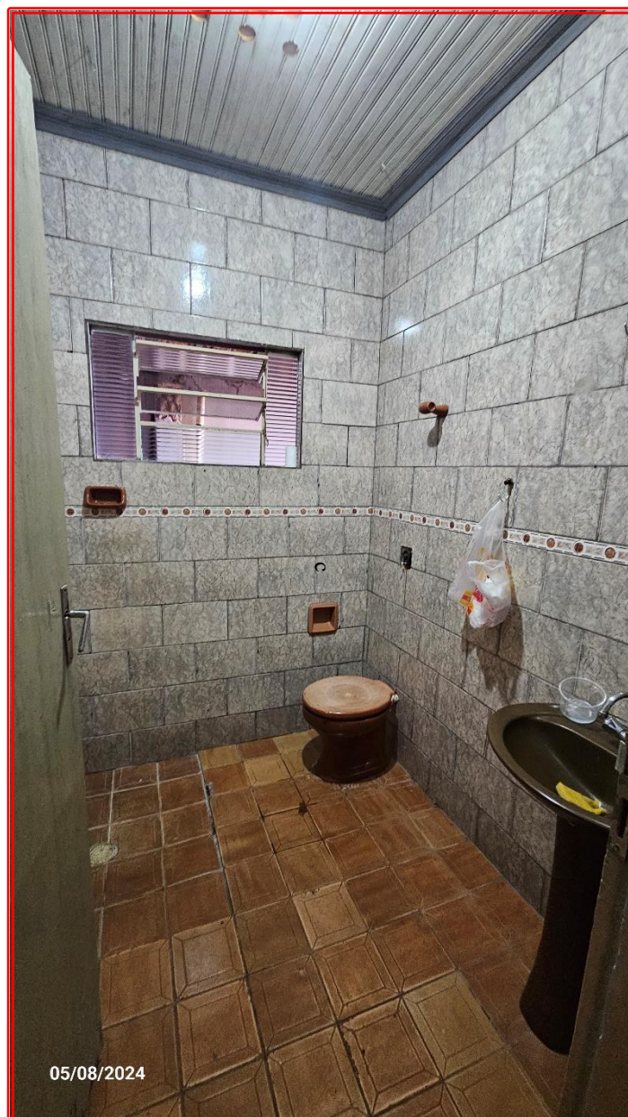
Foto 04: Aspecto geral do banheiro.
