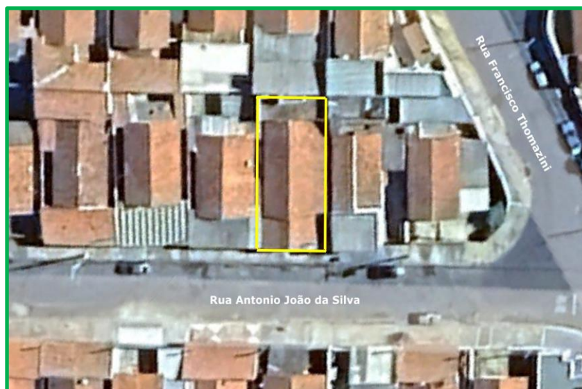
Figura 02: Vista aérea do imóvel inspecionado.
