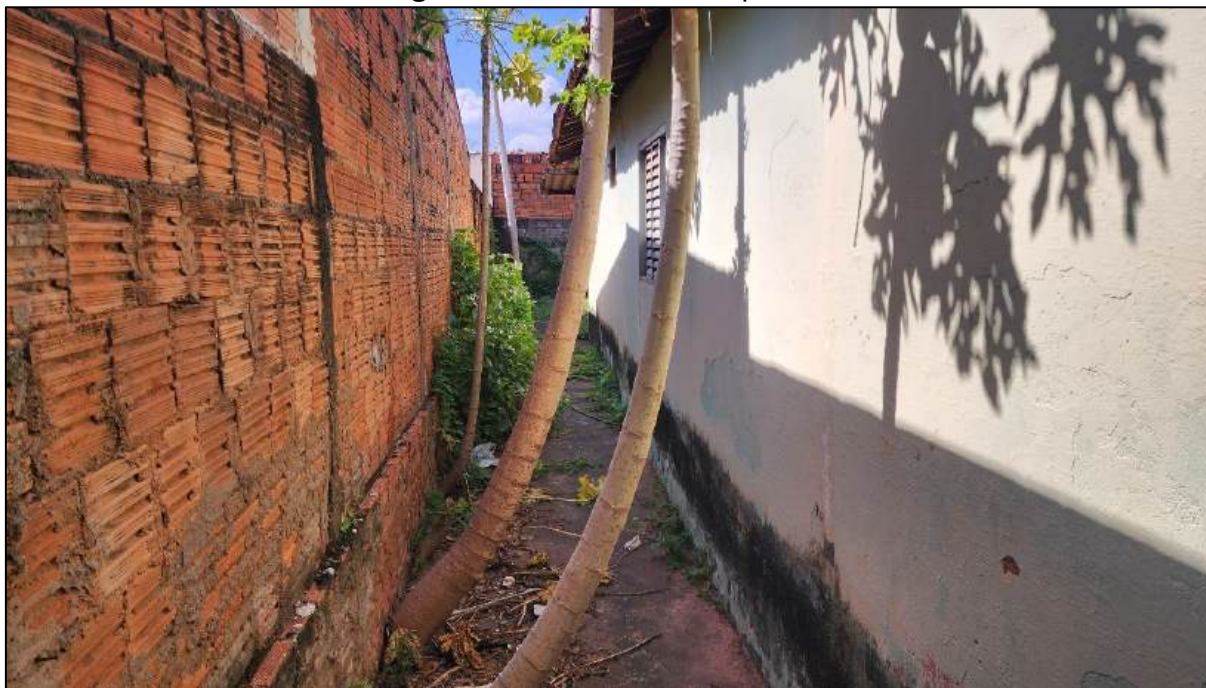
Figura 19 – Corredor à esquerda
