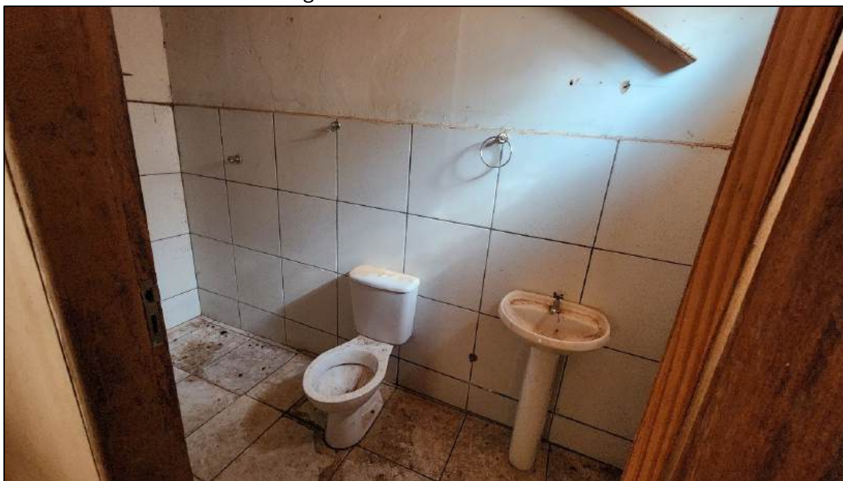
Figura 18 – Banheiro da suíte
