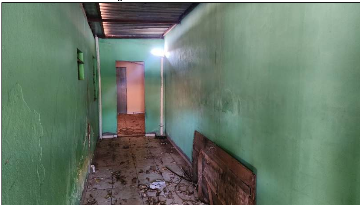
Figura 8 – Corredor lateral à direita
