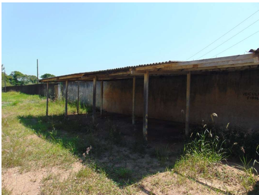
Figura 4.14 Edificação provisória de estacionamento
