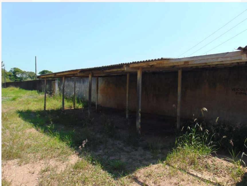
Figura 4.5 Cobertura provisória de estacionamento
