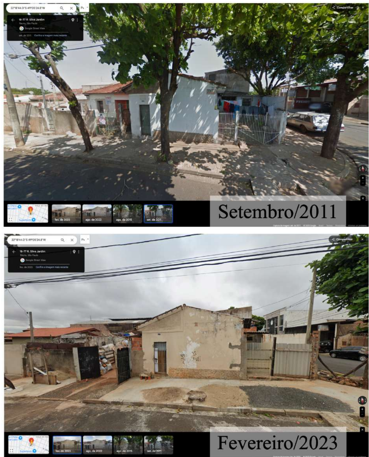
Figura 3 – Situação da fachada do imóvel em 2011 e 2023 (Fonte: Google Maps).
