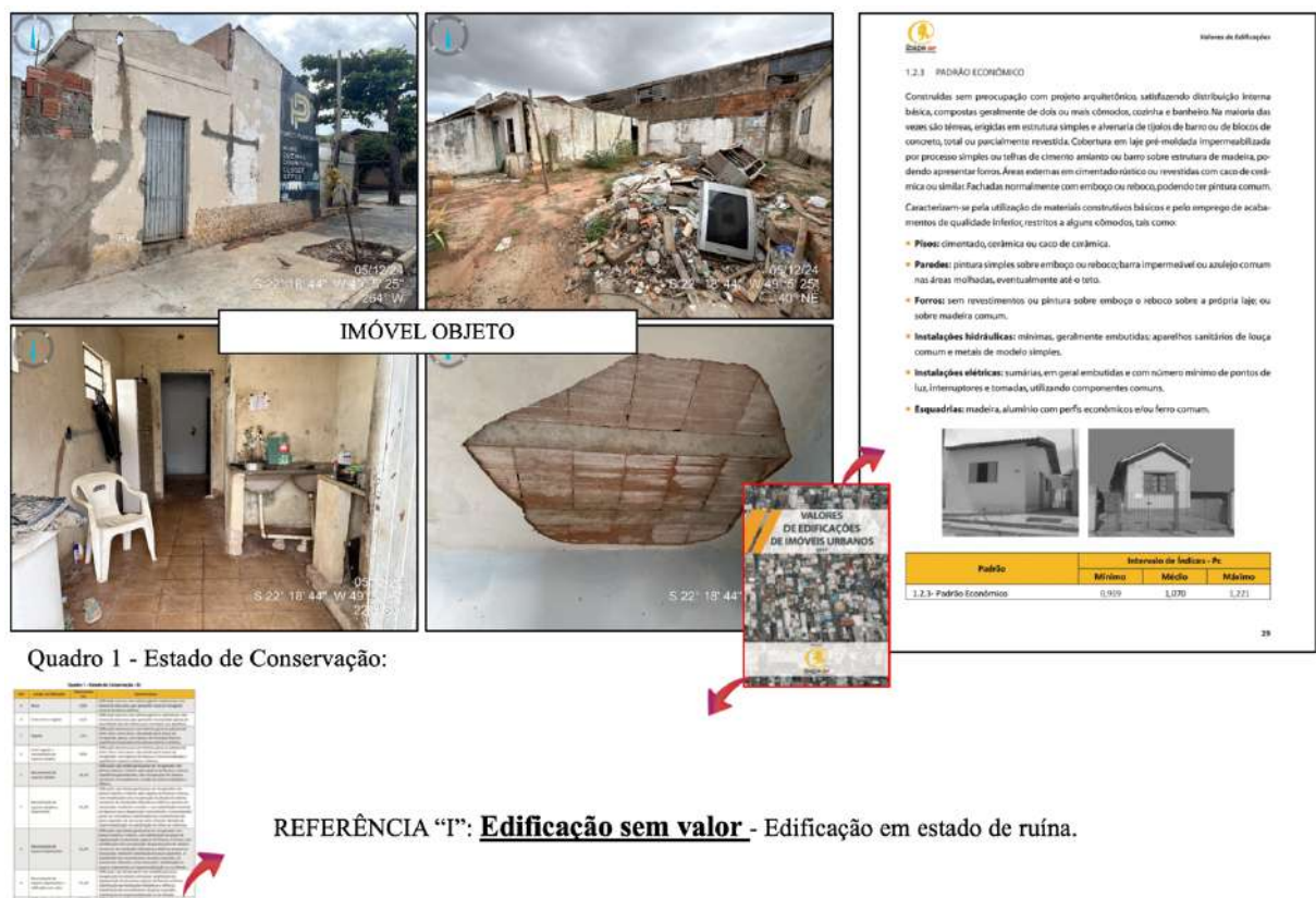
Figura 6 – Tipologia Construtiva e Estado de Conservação da Parte Residencial (IBAPE, 2017).
