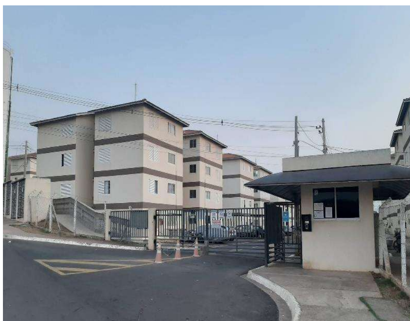
FACHADA CONDOMÍNIO “RESIDENCIAL VIDA NOVA II” Avenida Aureliano Fernandes de Araújo Neto, 571 – Vale do Sol
