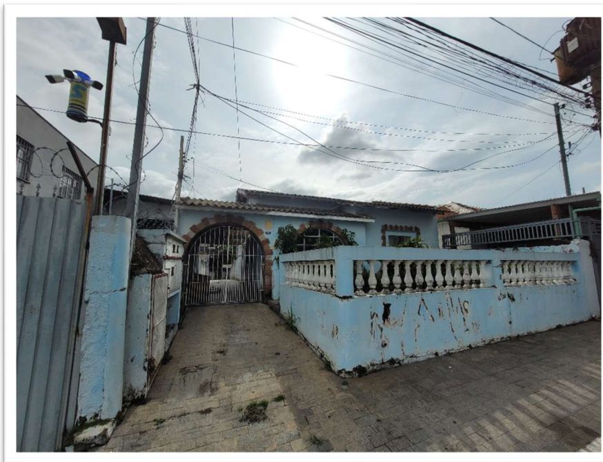
FOTO 02 – VISTA DA FACHADA FRONTAL DO IMÓVEL
