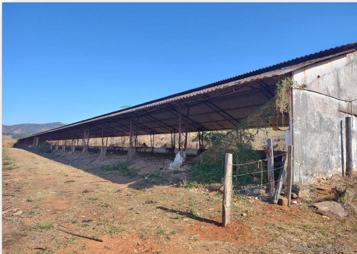
Visão de um dos seis galpões para granja – Estrutura metálica
