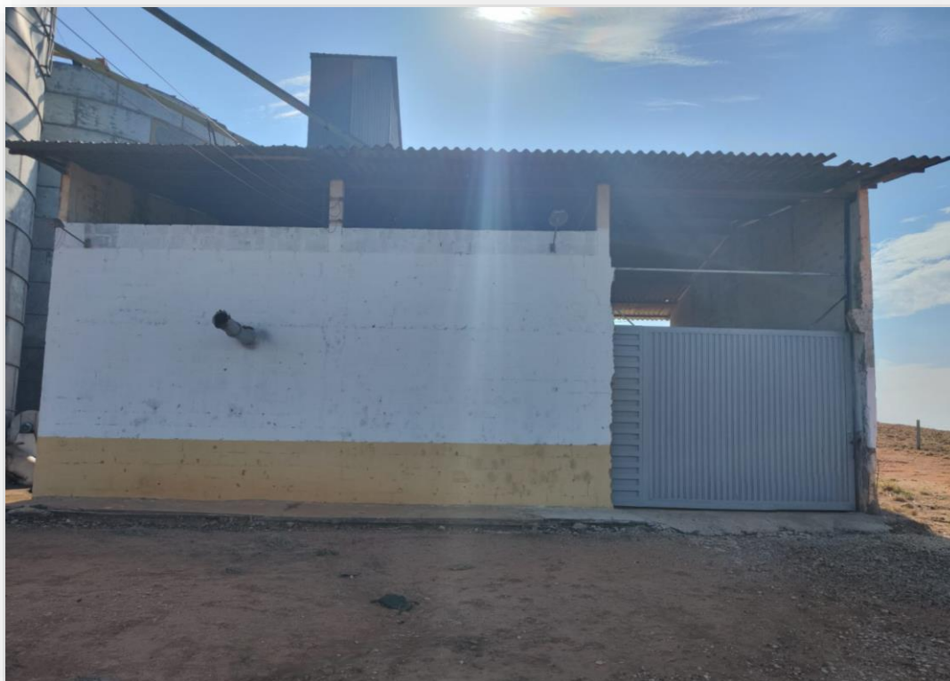
Galpão dos silos
