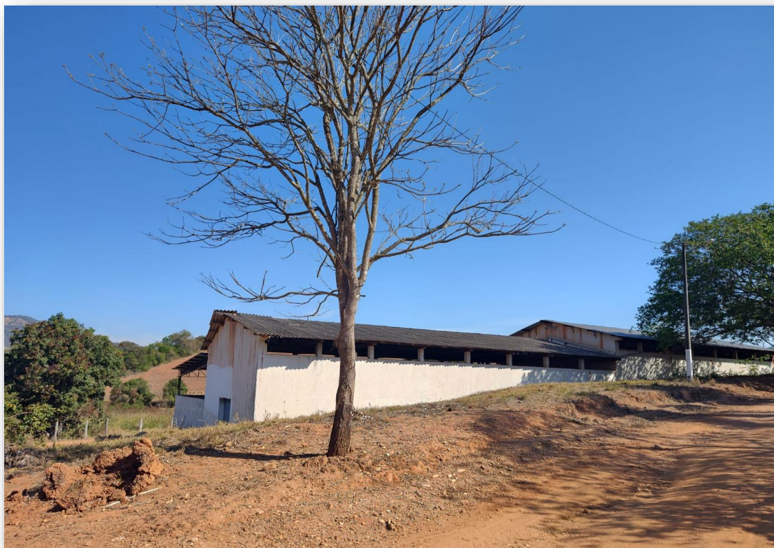
Edificação da máquina de beneficiamento de café
