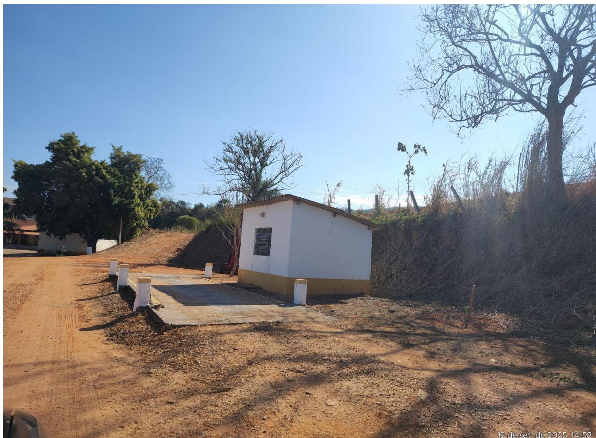
Edificação da balança (30 toneladas)
