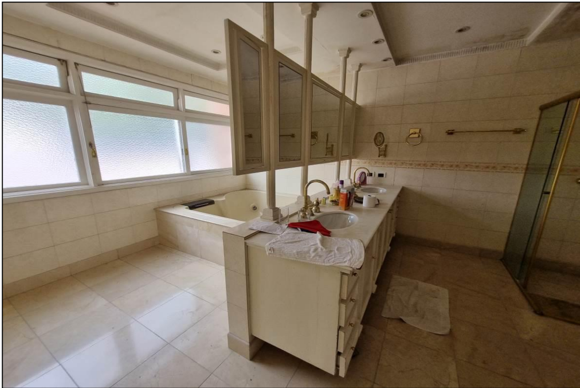
Foto nº 22: Vista do banheiro da suíte. Suas principais características construtivas são: piso cerâmico, paredes azulejadas até o teto, forro rebaixado em gesso e esquadrias de madeira.
