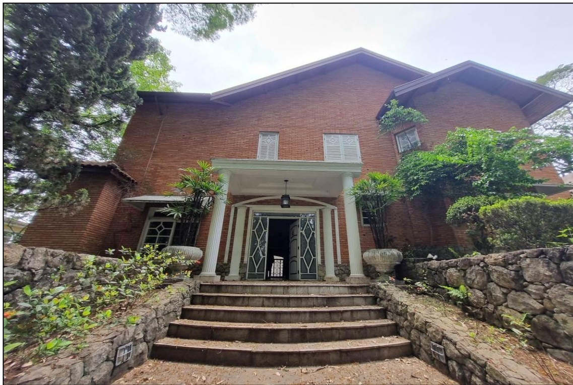
Foto nº 4: Detalhe do acesso principal do imóvel.
