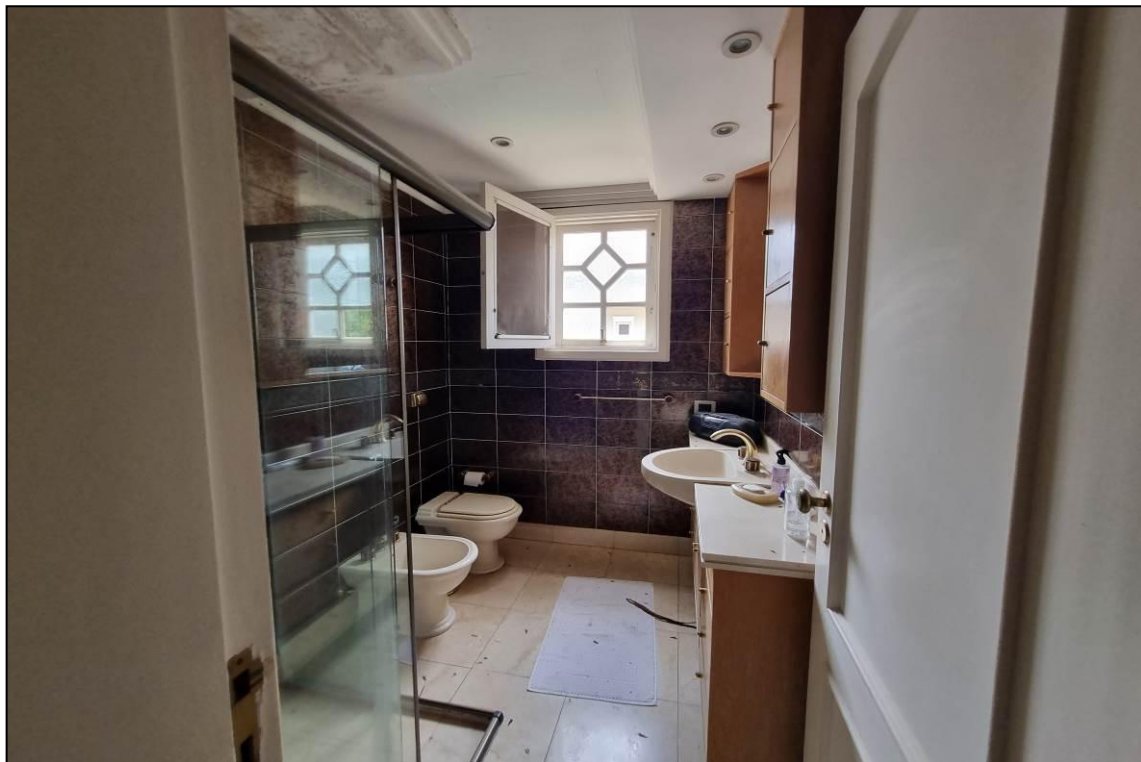
Foto nº 20: Vista do banheiro da suíte. Suas principais características construtivas são: piso cerâmico, paredes azulejadas até o teto, forro rebaixado em gesso e esquadrias de madeira.
