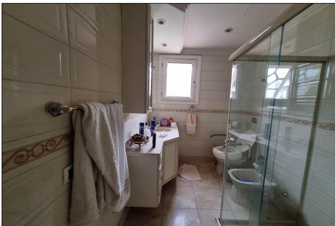
Foto nº 30: Vista do banheiro da suíte. Suas principais características construtivas são: piso cerâmico, paredes azulejadas até o teto, forro rebaixado em gesso e esquadrias de madeira.
