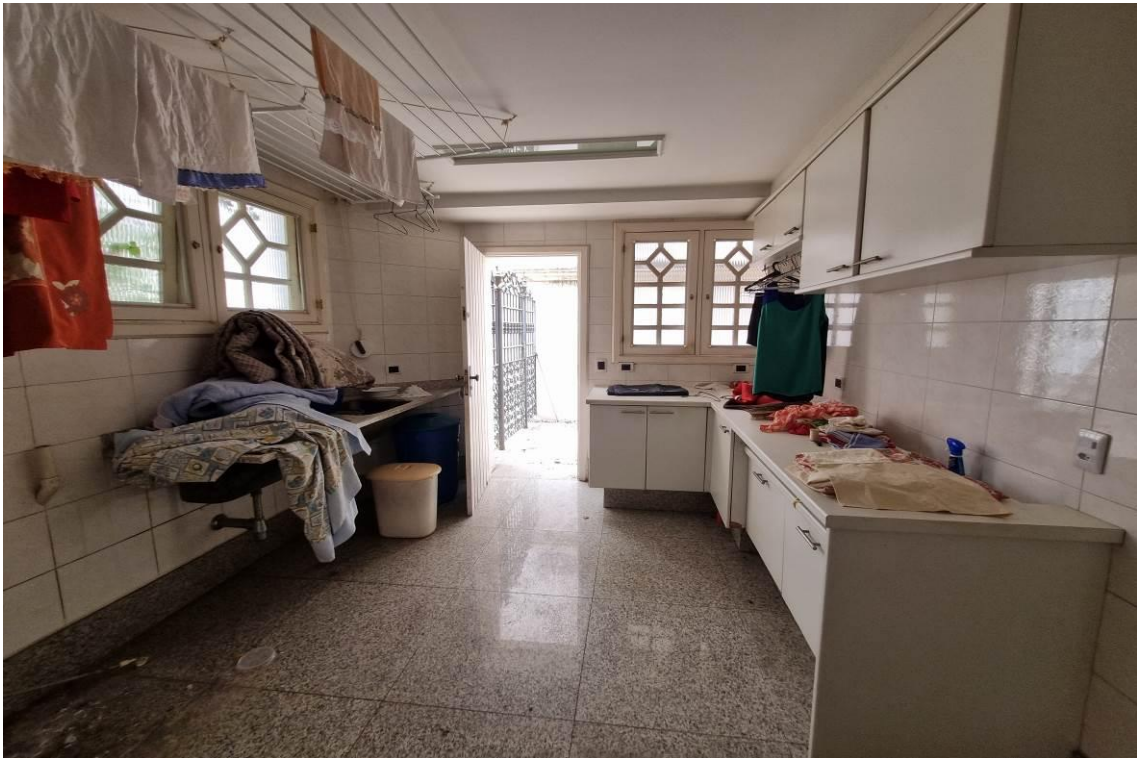
Foto nº 12: Vista da área de serviço. Suas principais características construtivas são: piso em granito, paredes azulejadas até o teto, forro rebaixado em gesso e esquadrias de madeira.
