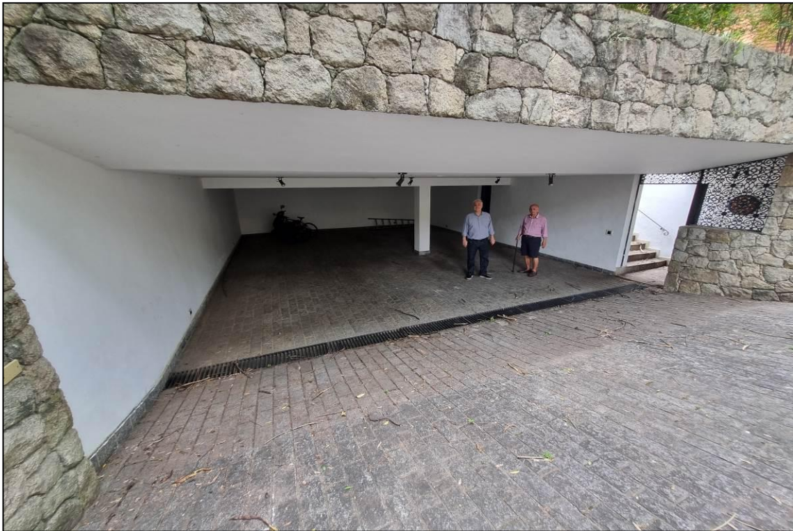
Foto nº 34: Vista do pavimento subsolo e garagem para estacionamento de veículos.
