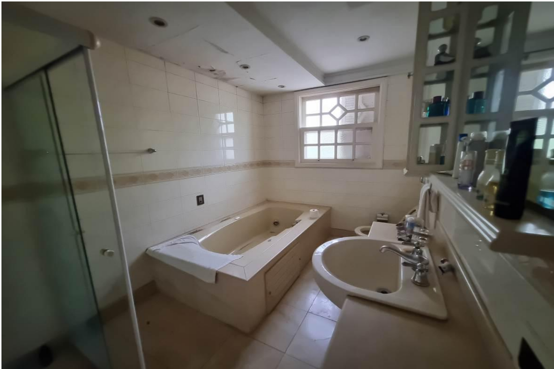
Foto nº 28: Vista do banheiro da suíte. Suas principais características construtivas são: piso cerâmico, paredes azulejadas até o teto, forro rebaixado em gesso e esquadrias de madeira.
