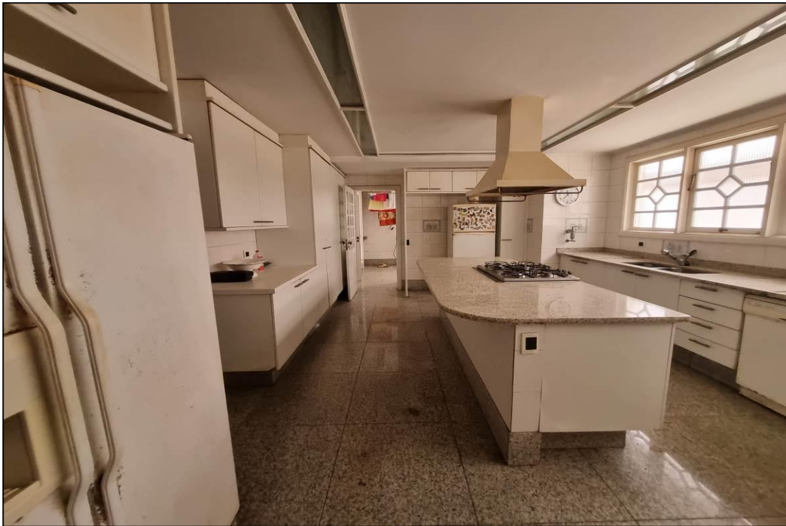
Foto nº 11: Vista da cozinha. Suas principais características construtivas são: piso em granito, paredes azulejadas até o teto, forro rebaixado em gesso e esquadrias de madeira.
