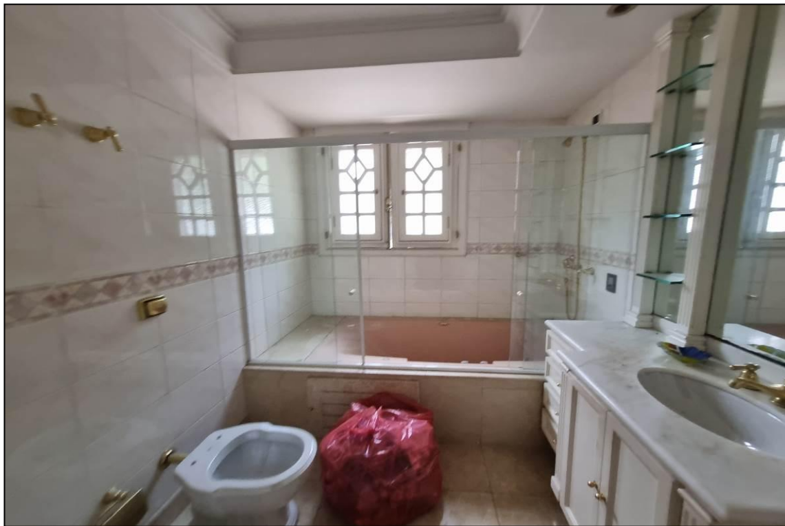
Foto nº 25: Vista do banheiro da suíte. Suas principais características construtivas são: piso cerâmico, paredes azulejadas até o teto, forro rebaixado em gesso e esquadrias de madeira.
