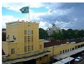
Estação Ferroviária e Biblioteca Municipal
