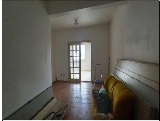
VISTA PARCIAL INTERNA DO IMÓVEL
