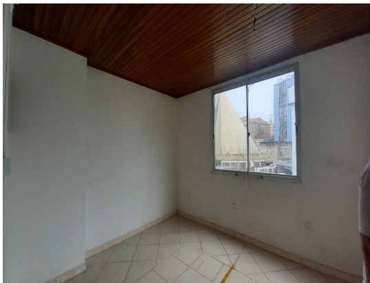
VISTA PARCIAL INTERNA DO IMÓVEL
