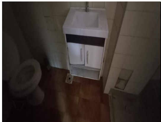
VISTA PARCIAL INTERNA DO BANHEIRO
