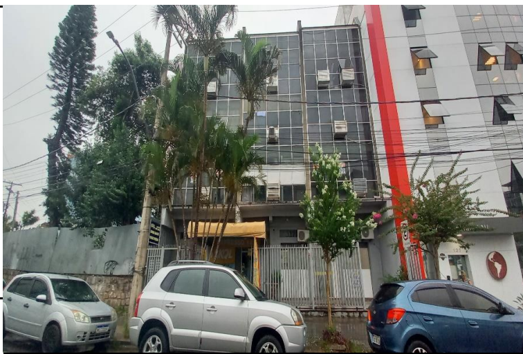
Foto da Fachada do Imóvel
