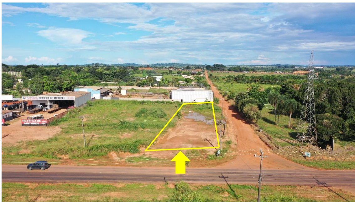
Vista aérea frontal do imóvel avaliando
