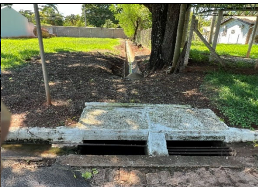
Foto 6. Vista da galeria de águas pluviais na lateral do lote
