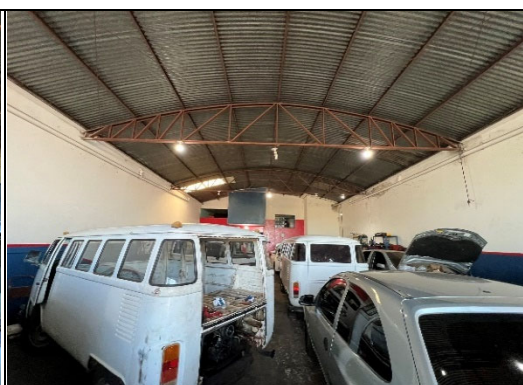
Foto 04. Vista da cobertura do imóvel
