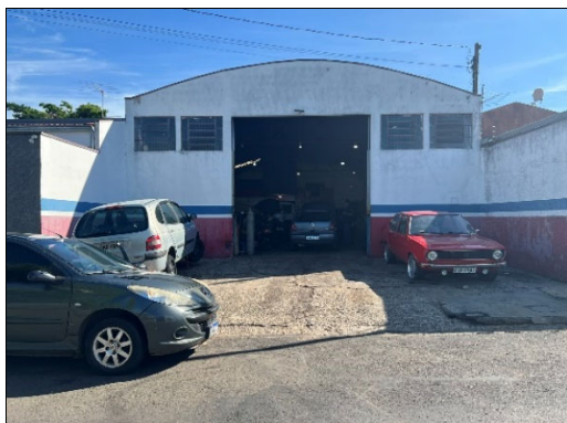
Foto 01. Vista da Fachada
