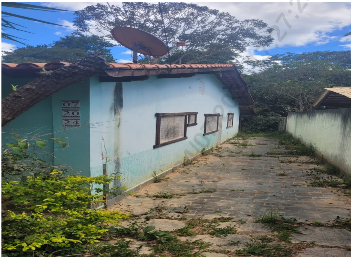
Lateral direita do imóvel a partir da entrada – Garagem descoberta
