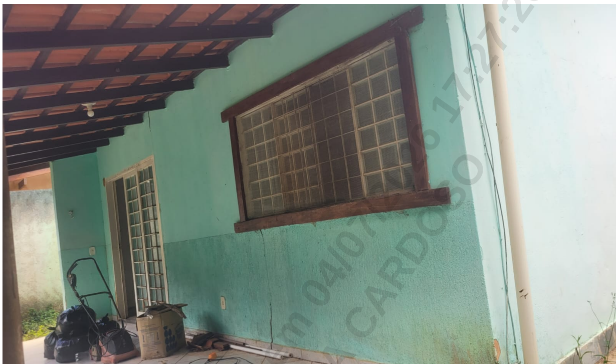
Fundos do imóvel - Entrada
