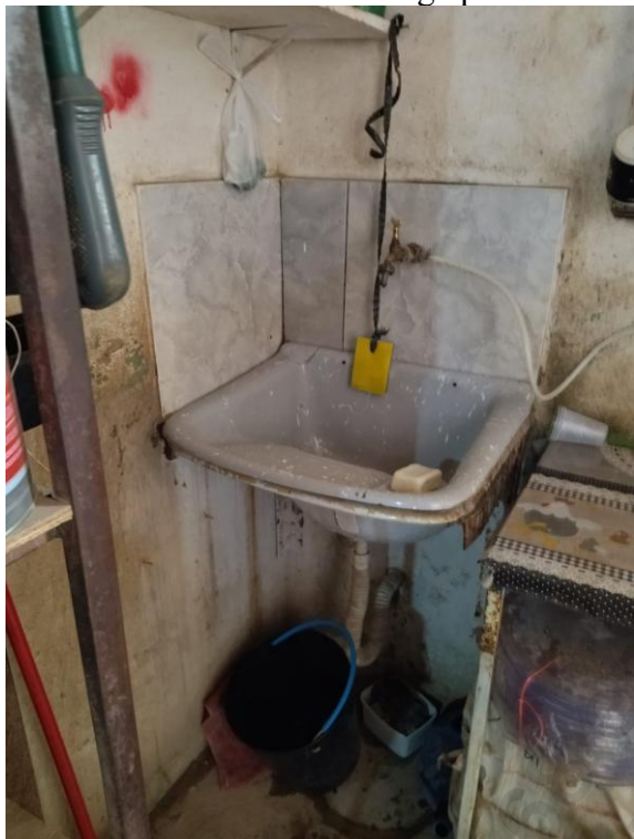
Fotos 7 a 9: Parte de trás do galpão
