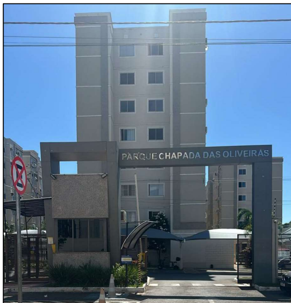
Figura 2 - Vista da fachada do apartamento.
