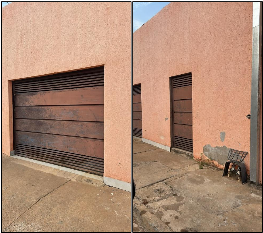
Figura 1 - Vista da fachada do imóvel.
