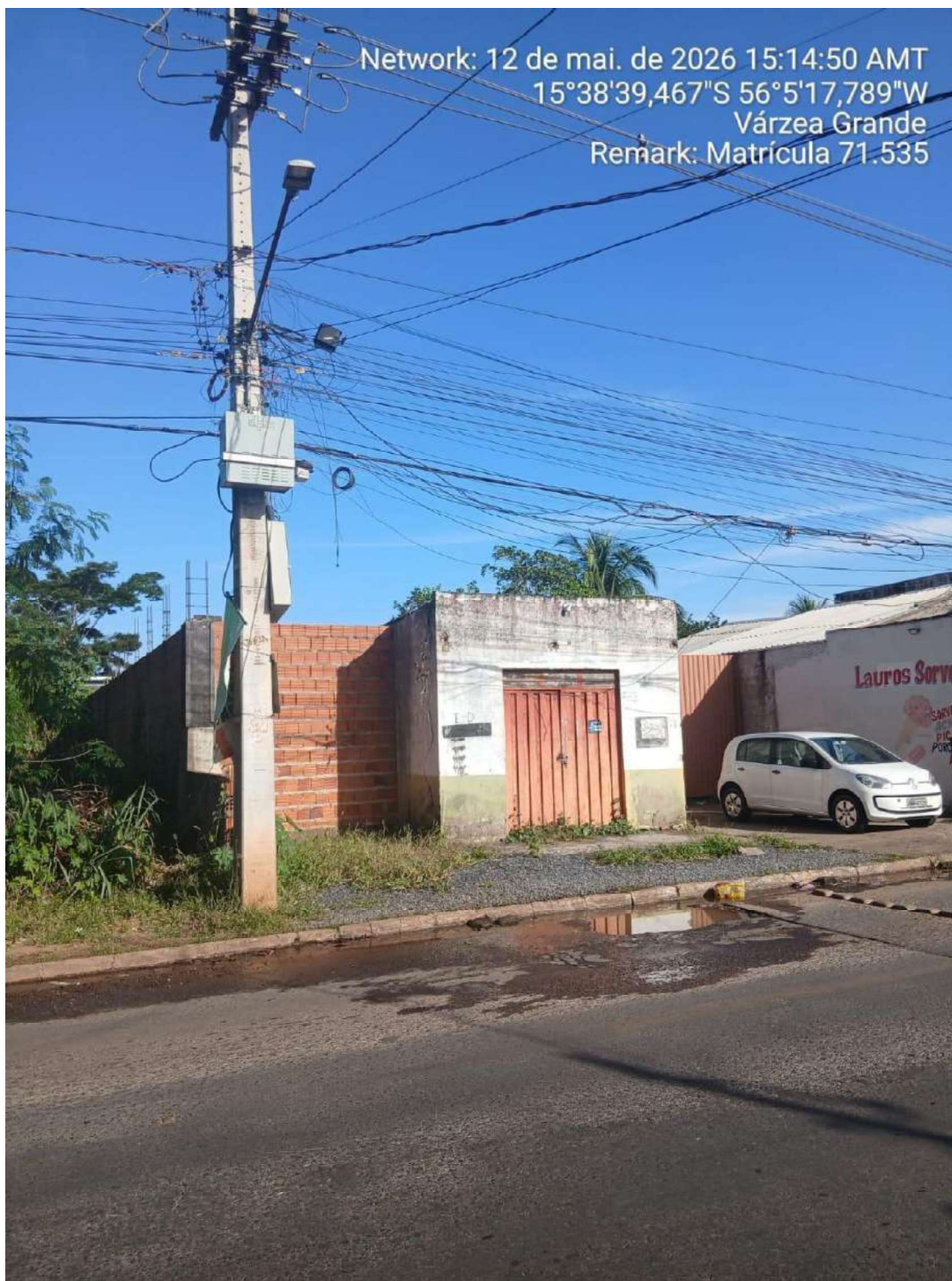
Figura 2 – Frente do imóvel mostrando o muro lateral de divisão de limites.
