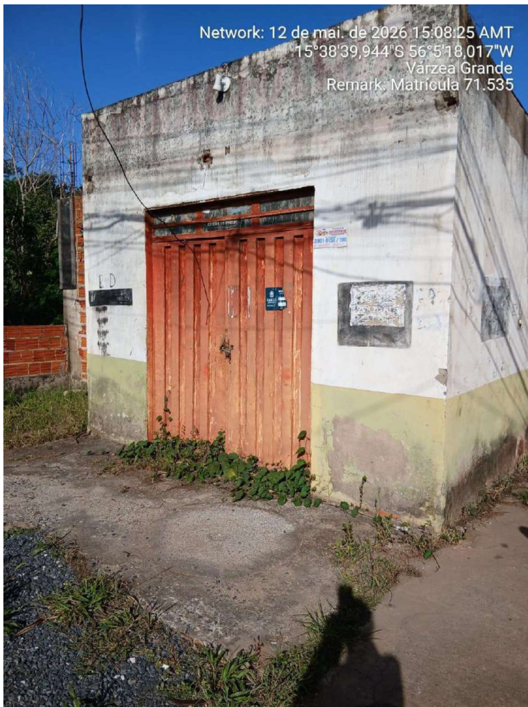
Figura 3 – Frente do imóvel.
