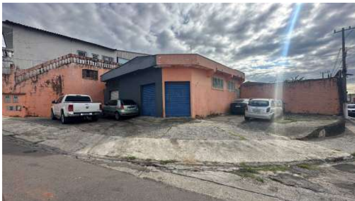
FOTO DE Nº 2. Fachada do galpão da mecânica
