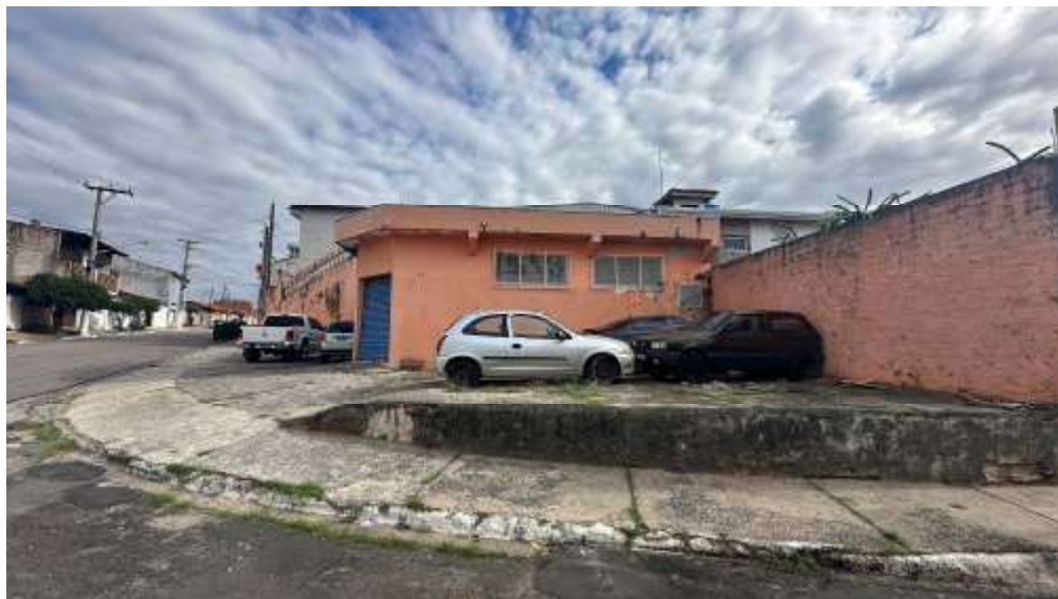
FOTO DE Nº 1. Fachada do galpão da mecânica
