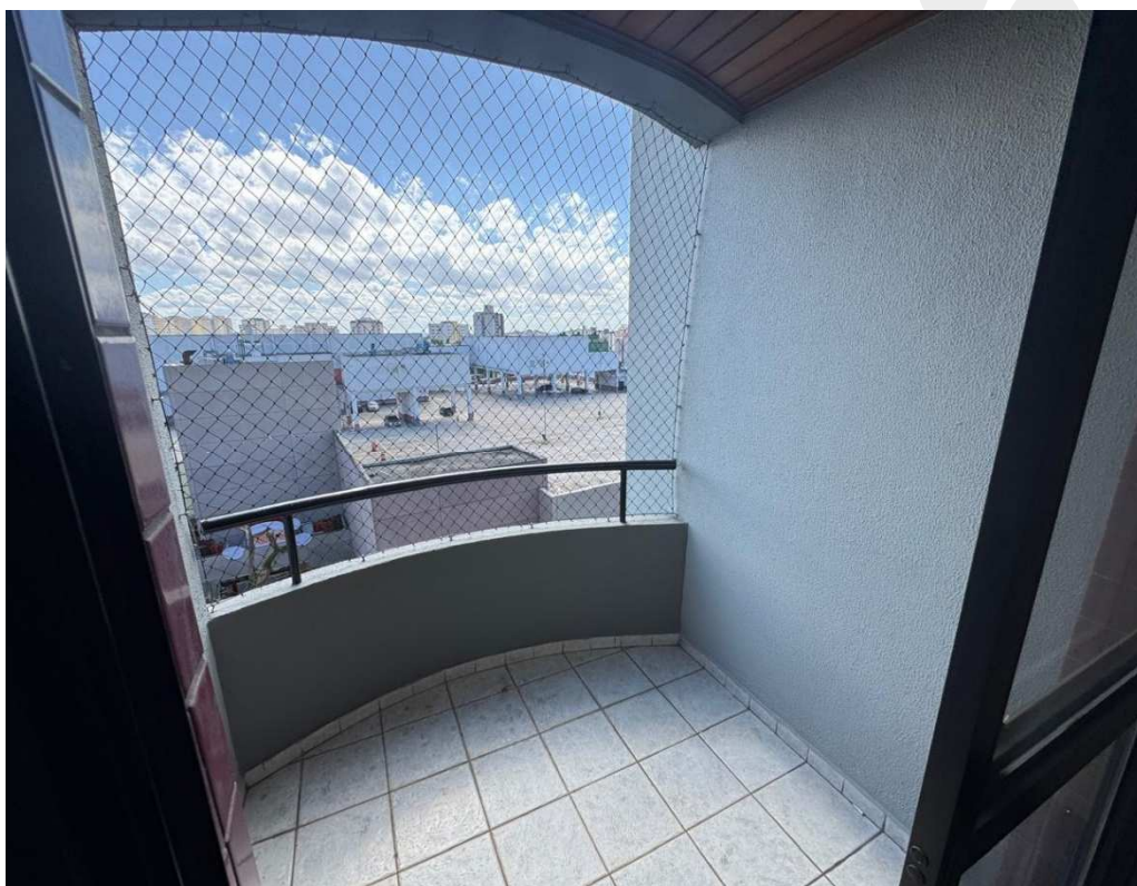
Fotografia 05 – Aspecto interno da Unidade n° 71.
