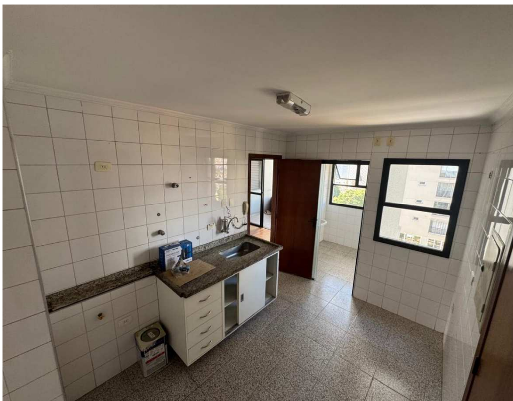
Fotografia 16 – Aspecto interno da Unidade n° 71.
