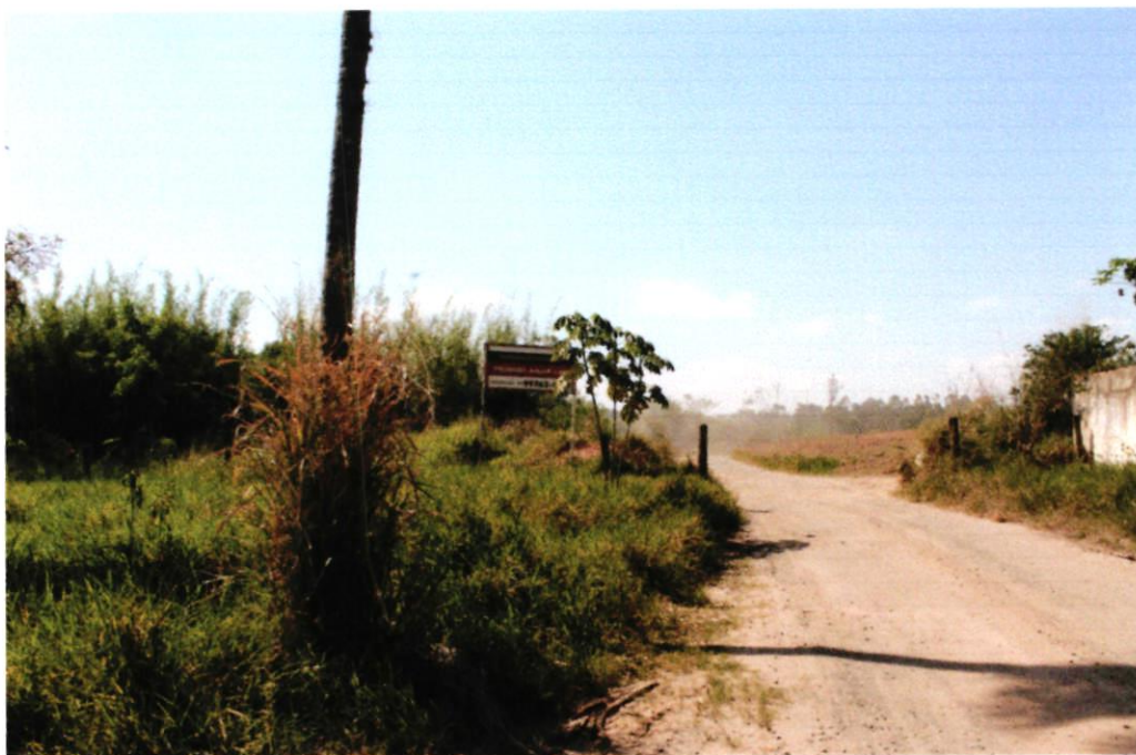
Foto nº 01 – Frente do imóvel para a antiga Estrada Itu – Sorocaba.
