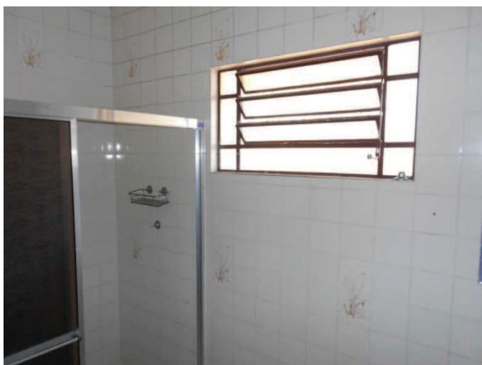
Banheiro, box 02 folhas frontal em alumínio, azulejo parede inteira.
