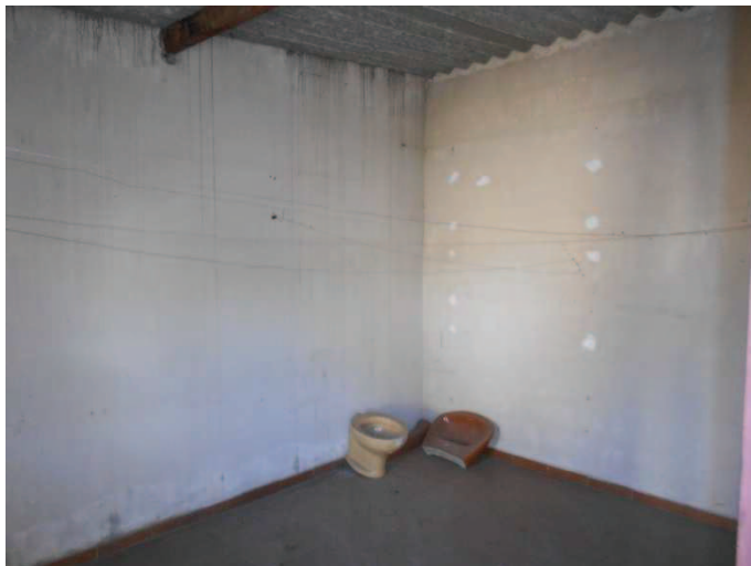
Quarto despejo, piso pedra mineira e cobertura telha de fibrocimento
