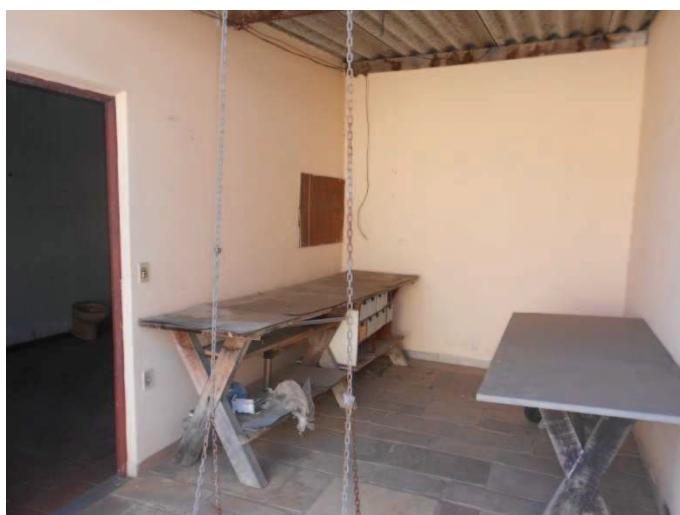
Rancho, piso pedra mineira, cobertura telha de fibrocimento
