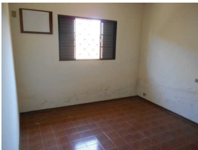
Dormitório 02, piso cerâmica
