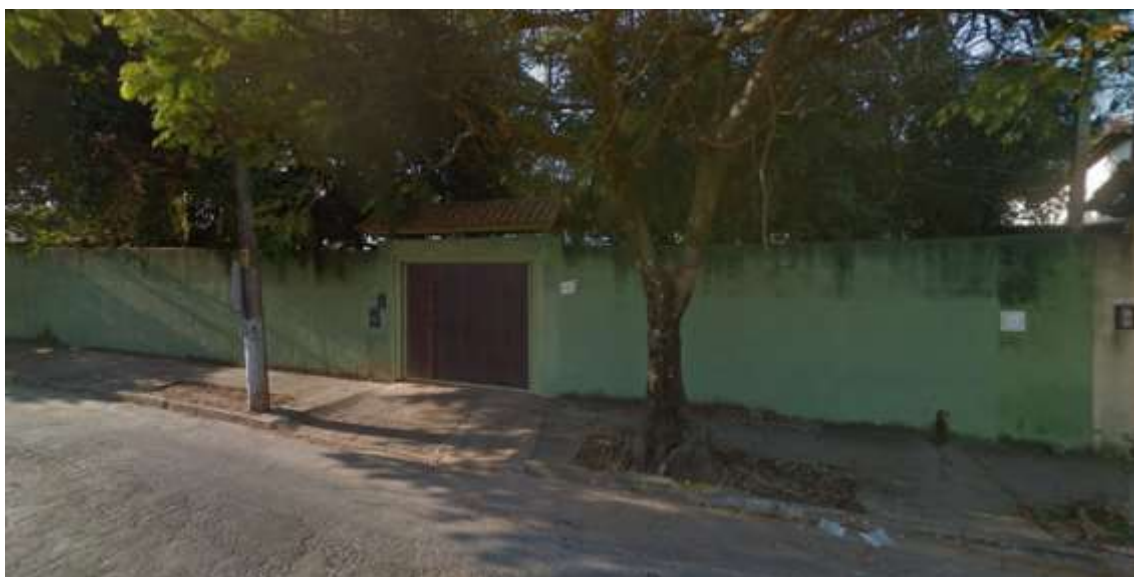
Foto 1 – Vista frontal do imóvel avaliando.
