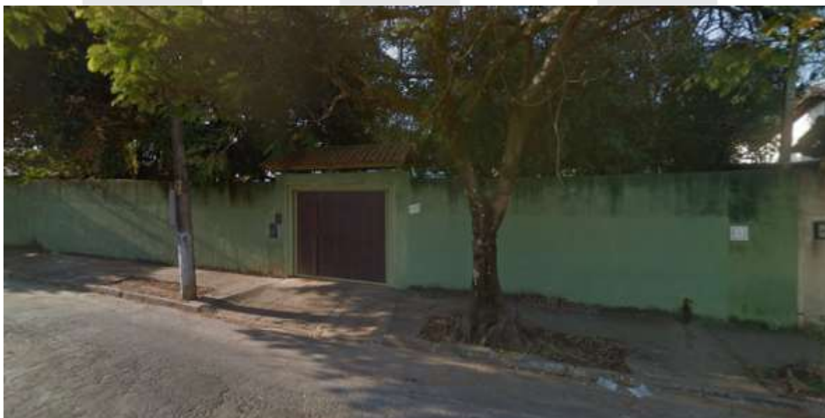
Foto 1 – Local da diligência pericial.
