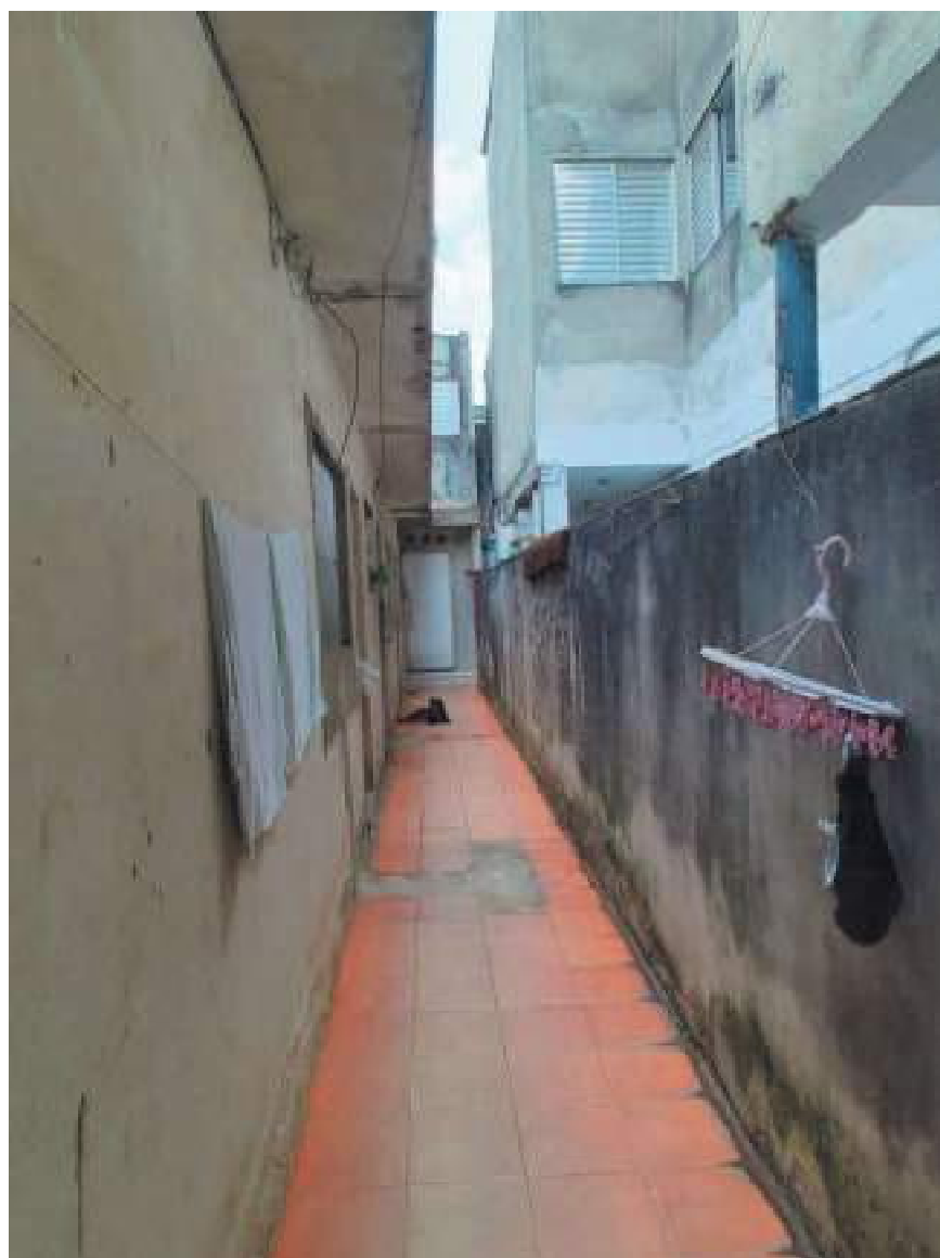
Corredor lateral de acesso às residências
