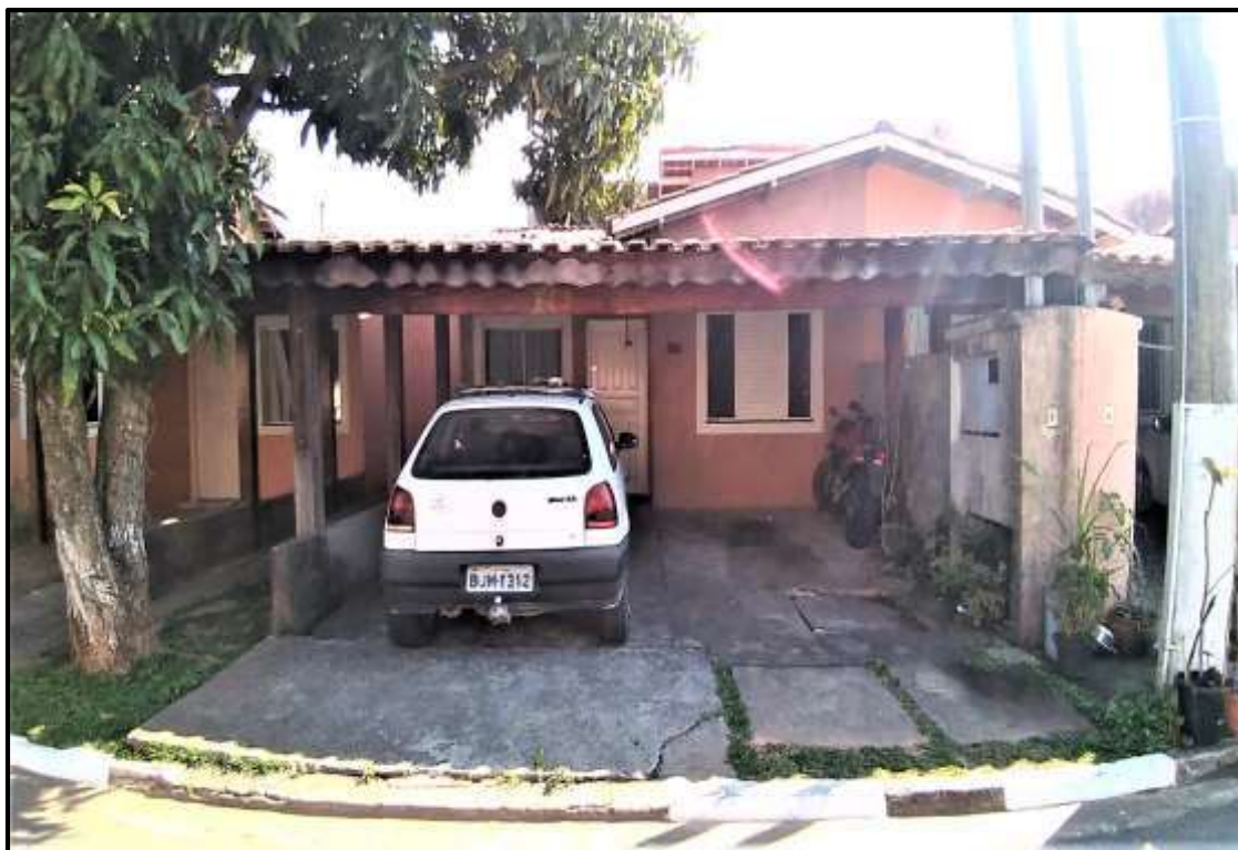
Vista da frente do imóvel avaliando.
