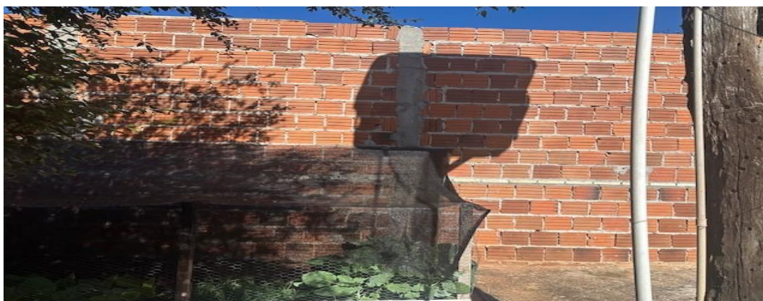
Foto 4 – Muro aos fundos, construído recentemente.
