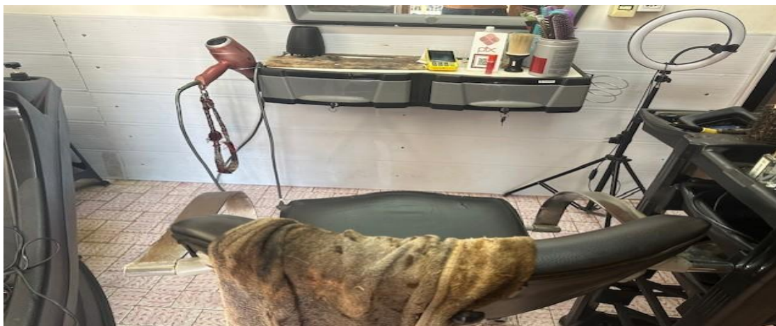
Foto 1 – Sala – Colocação de pvc para cobrir área da parede que se encontrava com o reboco danificado.
