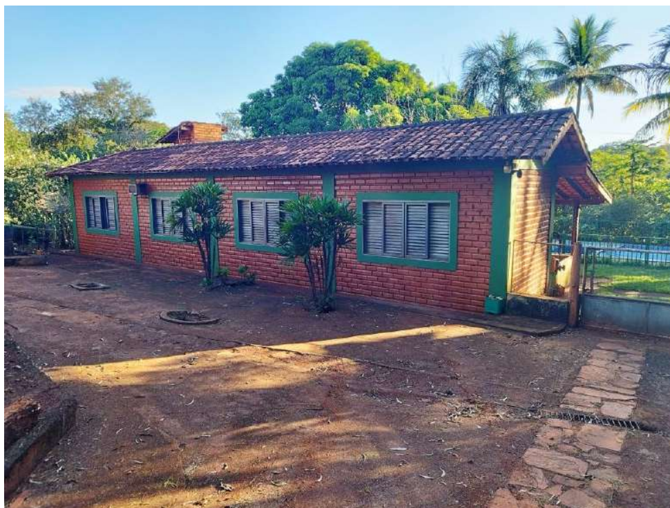
Imagem-12 – Edificação Existente – Casa 02 Fonte: autor, data 15/04/26.
