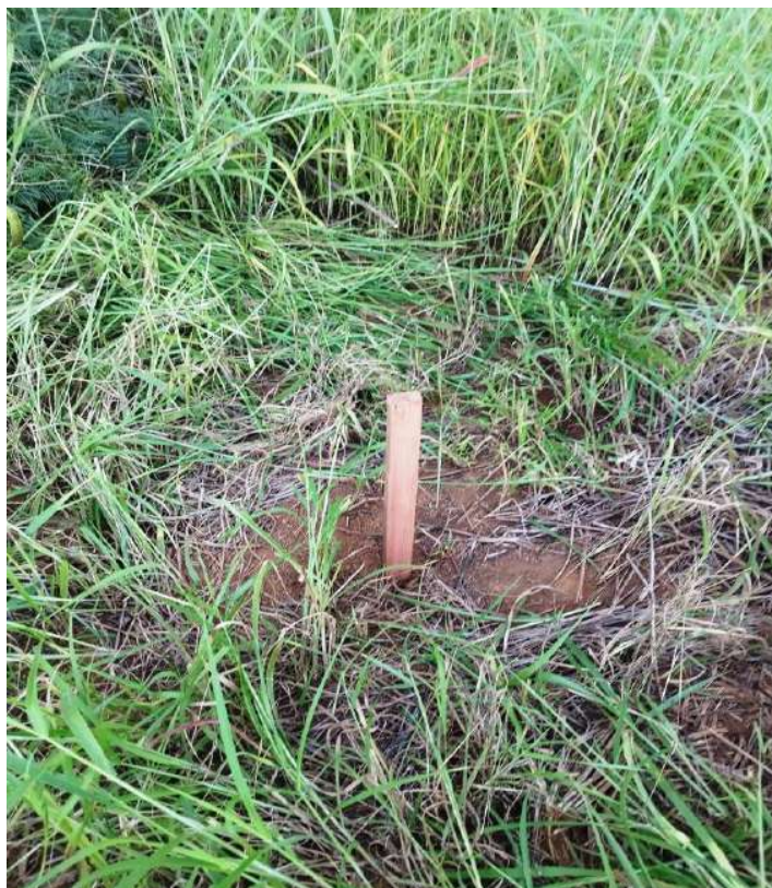
Imagem-10 – Fixação de Marco da Divisa Fonte: autor, data 15/04/26.
