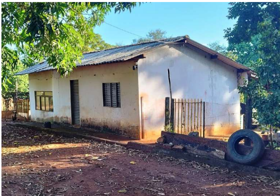
Imagem-11 – Edificação Existente – Casa 01 Fonte: autor, data 15/04/26.
