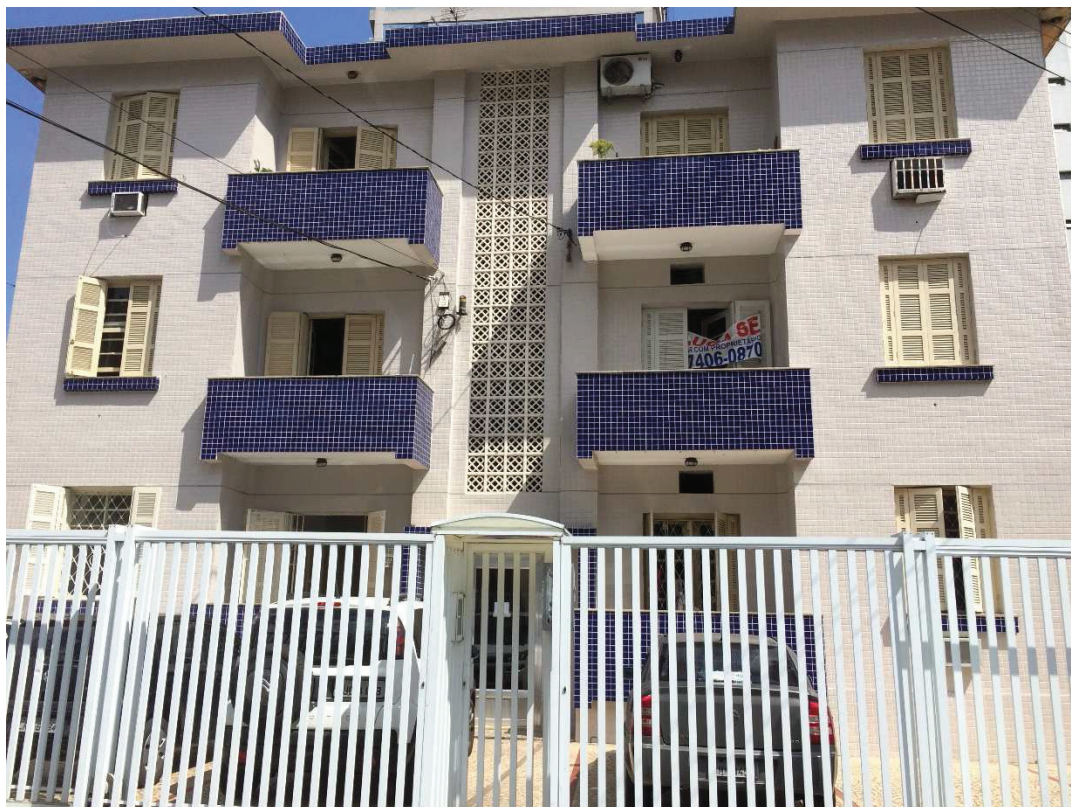
FOTO 01 - Vista fachada da frente Edifício Morada do Sol (10/09/2018)
