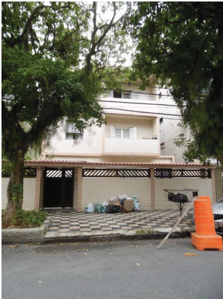
FOTO 01: Vista da fachada do imóvel.
