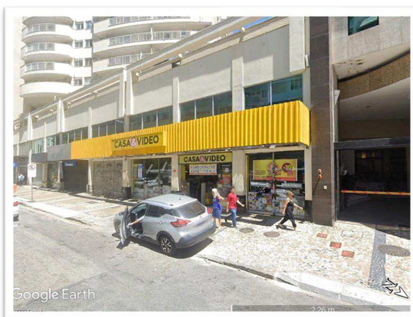
Figura 5 - vista da fachada do imóvel
