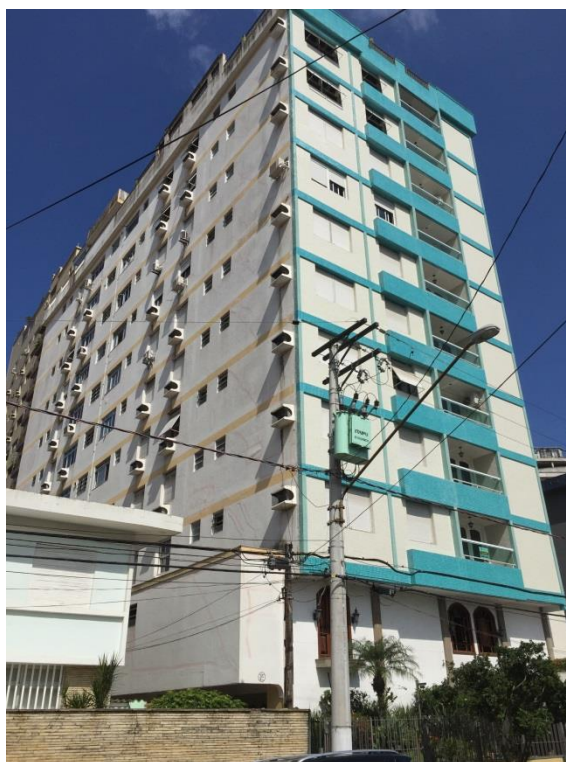
Figura 2: Vista geral do imóvel.
