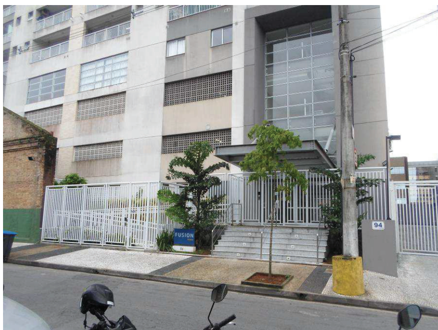
Acima, tem-se outra tomada da testada do edifício, onde é possível observar o acesso à pedestres e veículos.
