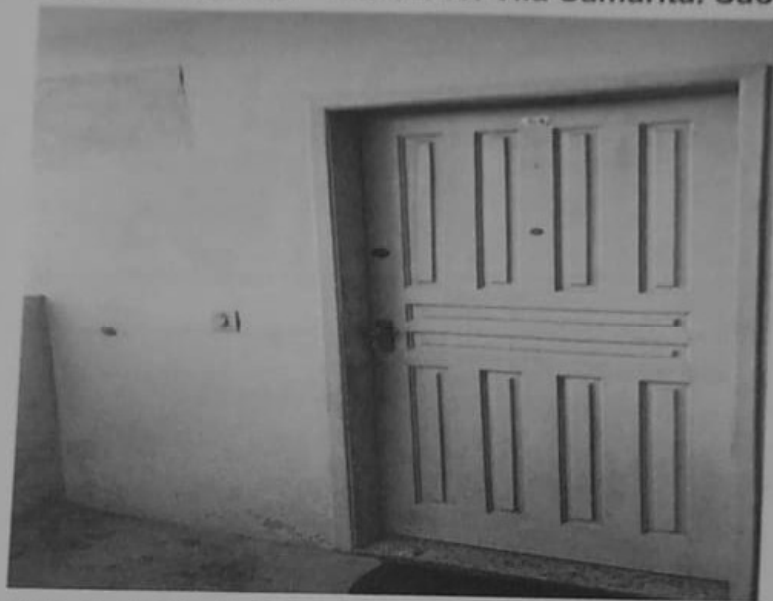
Foto 5 - Porta de Entrada do apartamento nº 206
