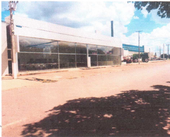
Vista externa da edificação – Fachada Lateral.
