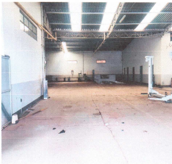
Vista interna da edificação – Sala de manutenção.
