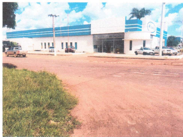
Vista externa da edificação – Fachada Lateral.
