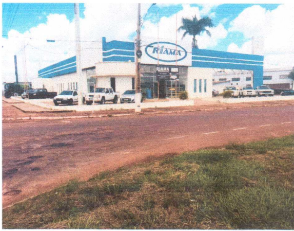
Vista externa da edificação – Fachada Frontal.
