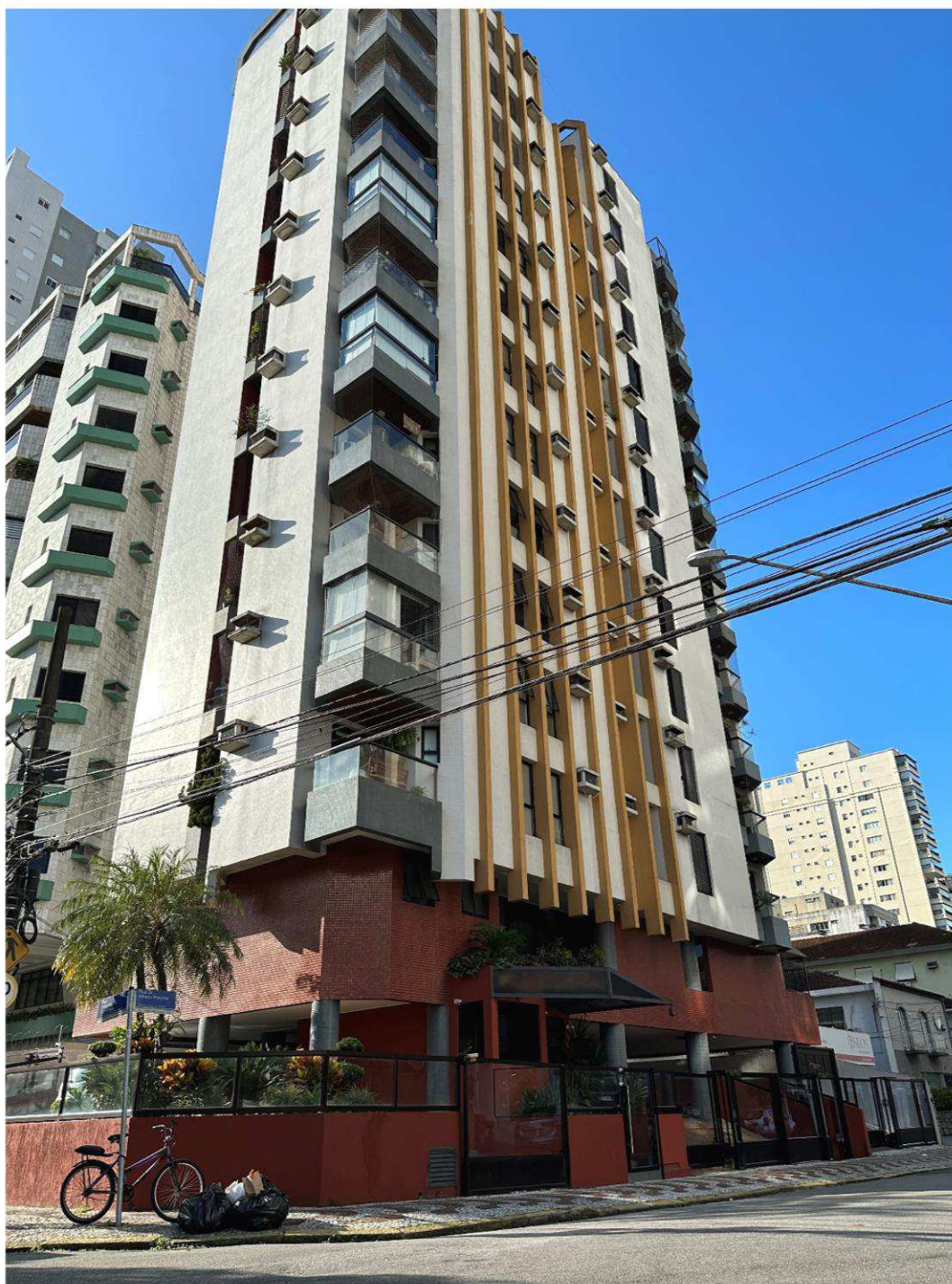
Figura 1 – Vista lateral do Edifício Porto de Espanha
