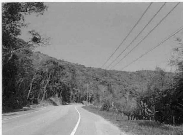
Trecho da rodovia sentido Bertiooga
