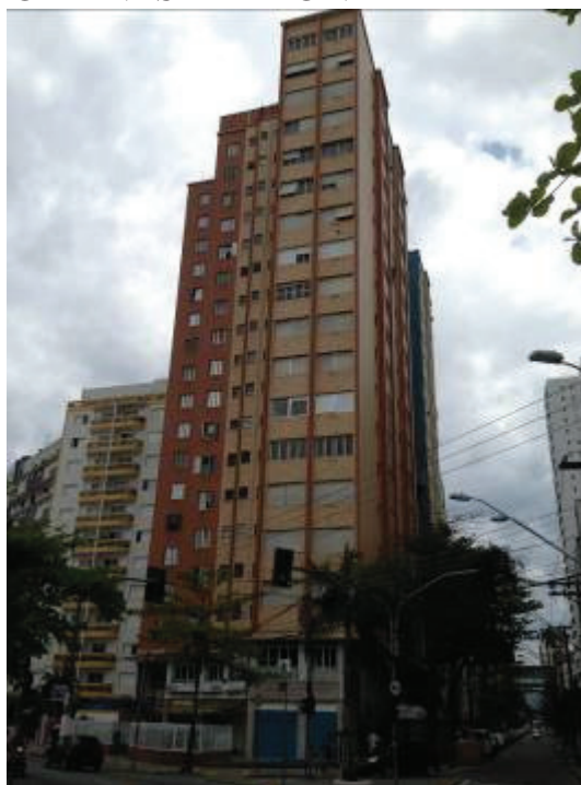
FOTO 1 – VISTA FRONTAL DA EDIFICAÇÃO
