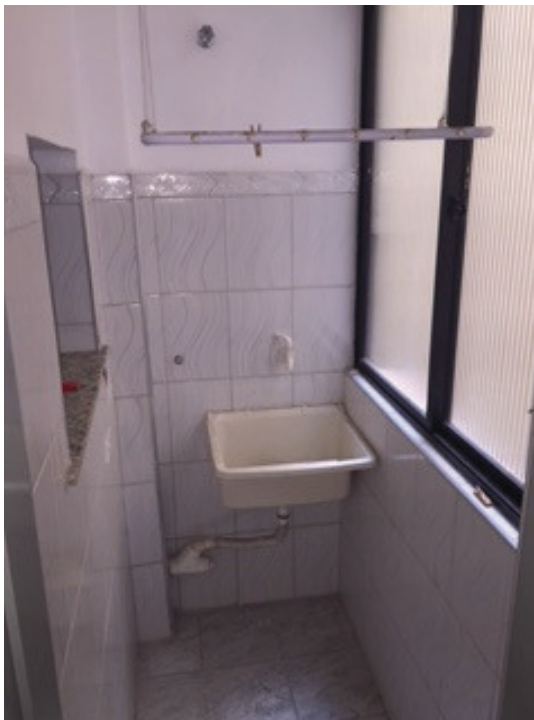
FOTO 6 – VISTA DA ÁREA DE SERVIÇO
