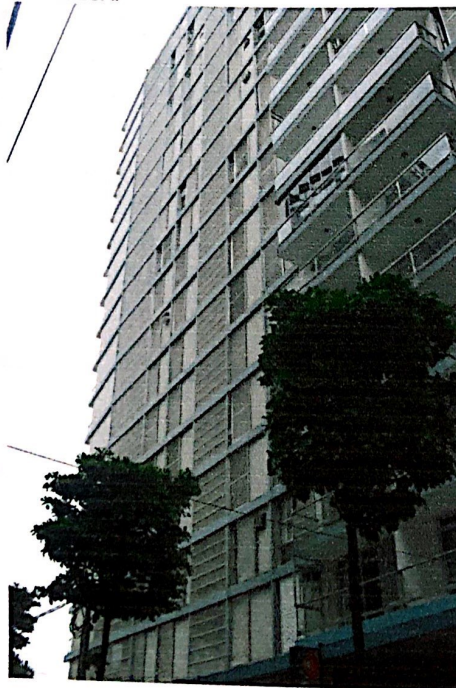
FOTO 04 - REGISTRO DE FACHADA LATERAL DESSE EDIFÍCIO VOLTADA PARA A RUA CARLOS AFONSECA.
