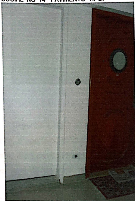
FOTO 08 - REGISTRO DO HALL DE ENTRADA SOCIAL NO 14º PAVIMENTO TIPO.
