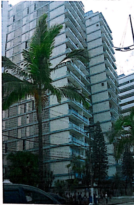
FOTO 02 - VISTA DE FACHADAS DOS BLOCOS QUE INTEGRAM O CONJUNTO TERTÚLIA.
