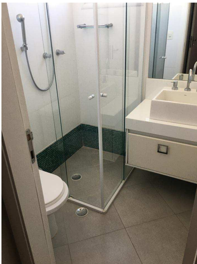
Figura 11: Banheiro da suíte.
