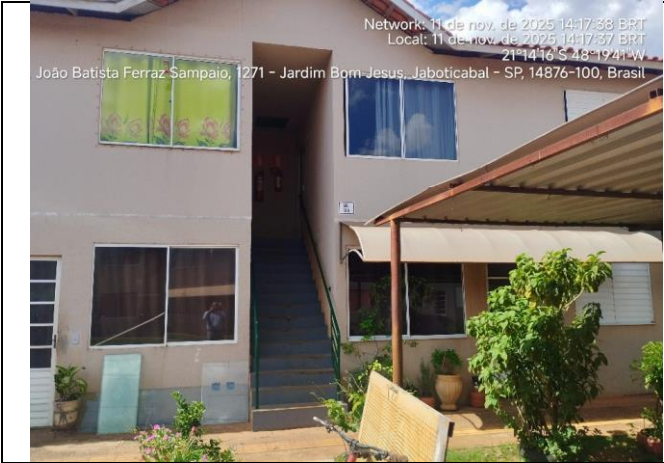
Fachada do Avaliando
