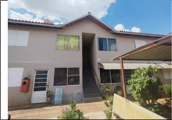
Fachada do Avaliando
