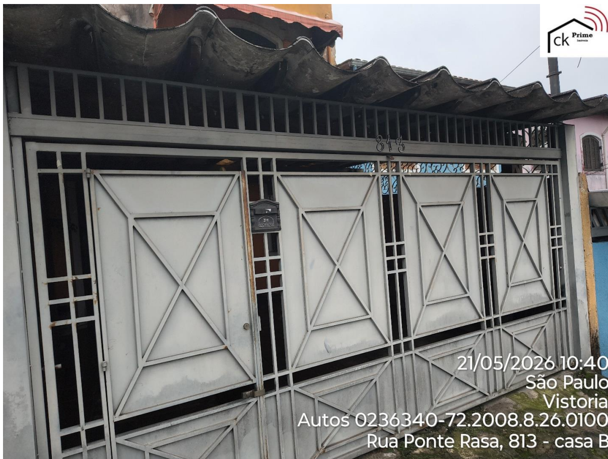
Foto 3 – Portão de ferro na entrada do imóvel e garagem
