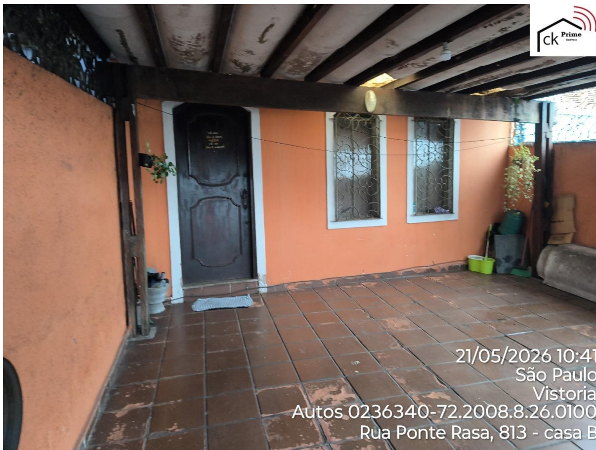
Foto 6 – Porta de entrada e interior da garagem
