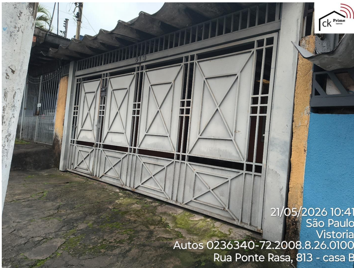
Foto 4 – Portão de ferro na entrada do imóvel e garagem
