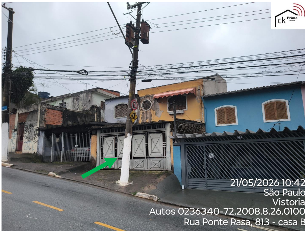
Foto 1 – Fachada do imóvel (seta verde)
