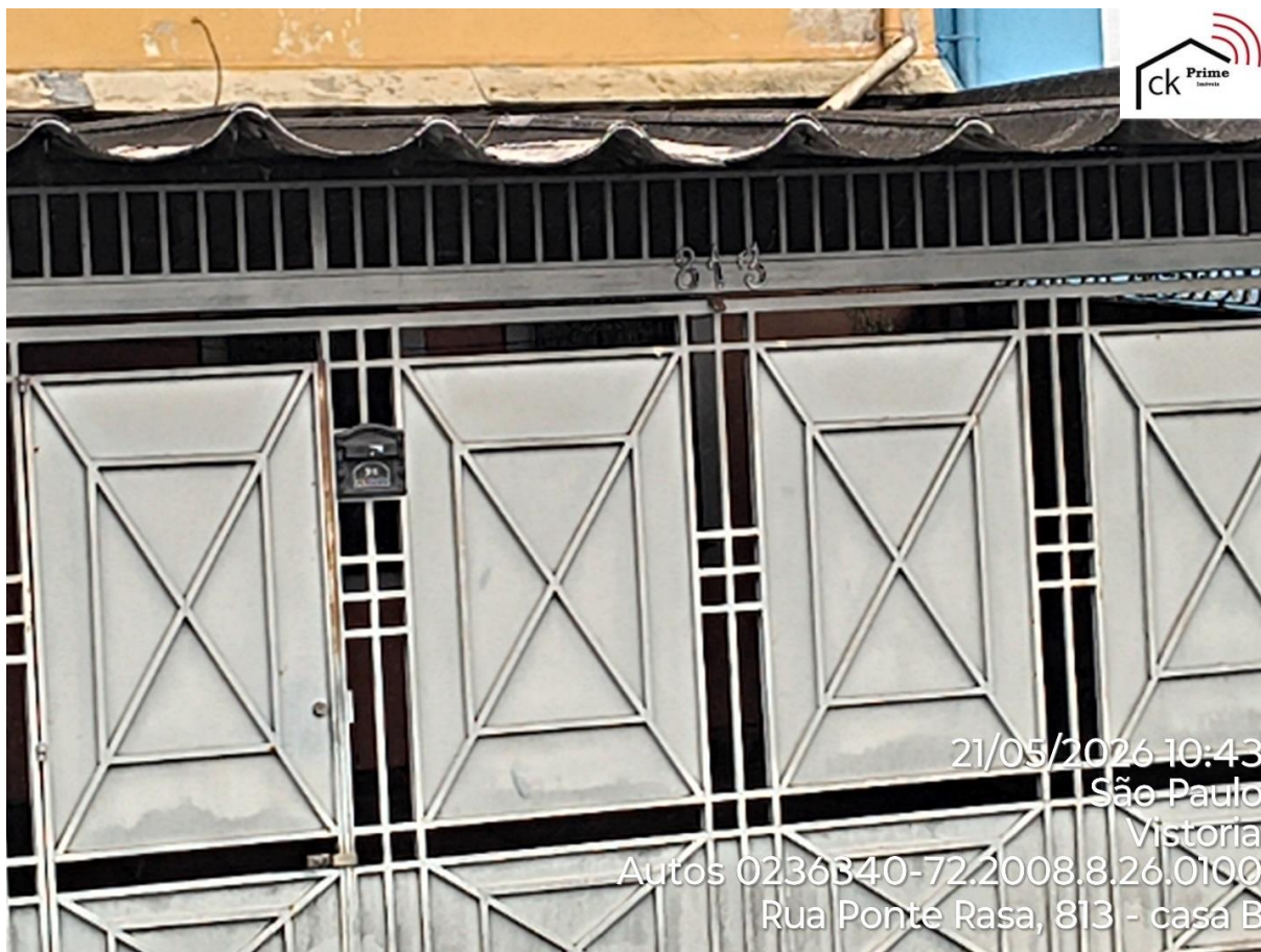
Foto 5 – Portão de ferro e telhas cobrindo a garagem do imóvel
