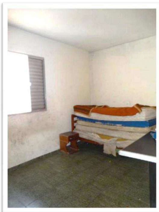
Foto nº 26. Vista parcial interna do imóvel objeto da vistoria – Residência do 1º pavimento.
