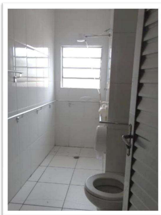
Foto nº 34. Vista parcial interna do imóvel localizado na Rua Raimundo Lúlio, 551 – Objeto da presente vistoria.
