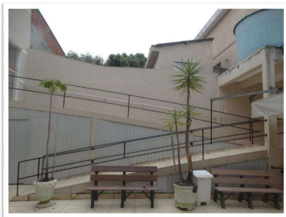
Foto nº 12. Vista parcial do imóvel objeto da vistoria – Rampa de acesso ao imóvel sob matrícula 171.748 (Casa de Repouso) à esquerda da imagem.
