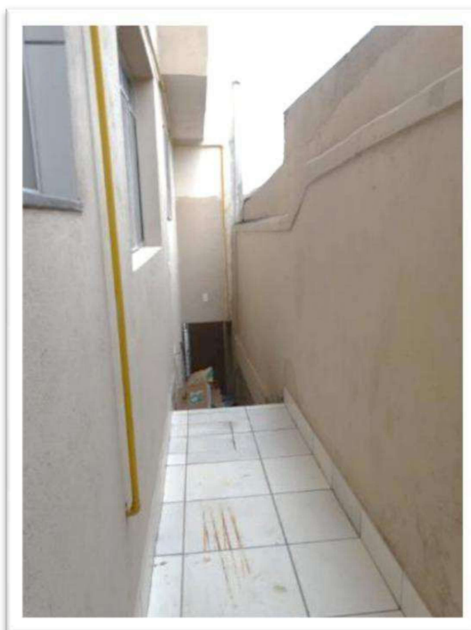
Foto nº 24. Vista parcial interna do imóvel localizado na Rua Raimundo Lúlio, 551 – Objeto da presente vistoria.
