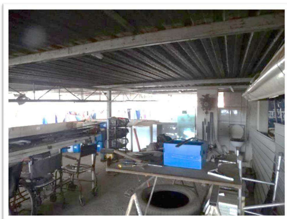
Foto nº 43. Vista parcial interna do imóvel objeto da vistoria – Terraço coberto.
