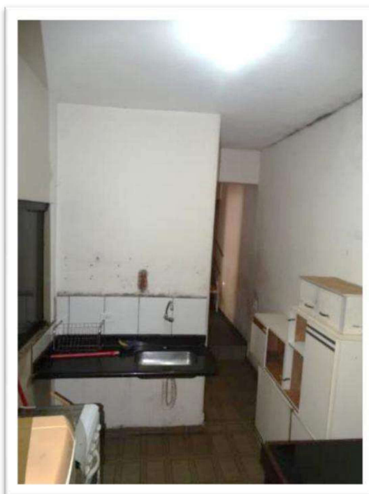
Foto nº 24. Vista parcial interna do imóvel objeto da vistoria – Residência do 1º pavimento.
