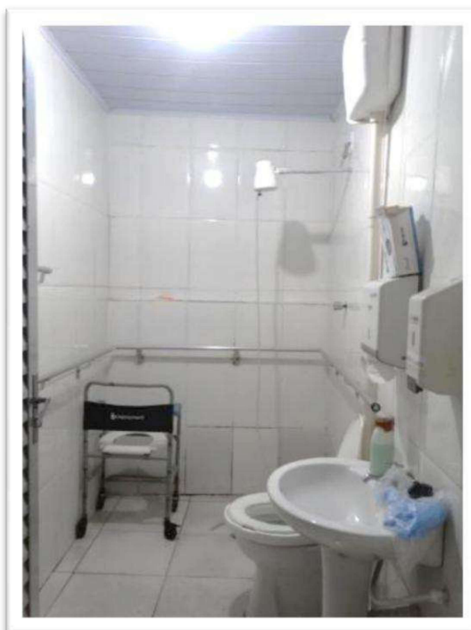
Foto nº 28. Vista parcial interna do imóvel localizado na Rua Raimundo Lúlio, 551 – Objeto da presente vistoria.
