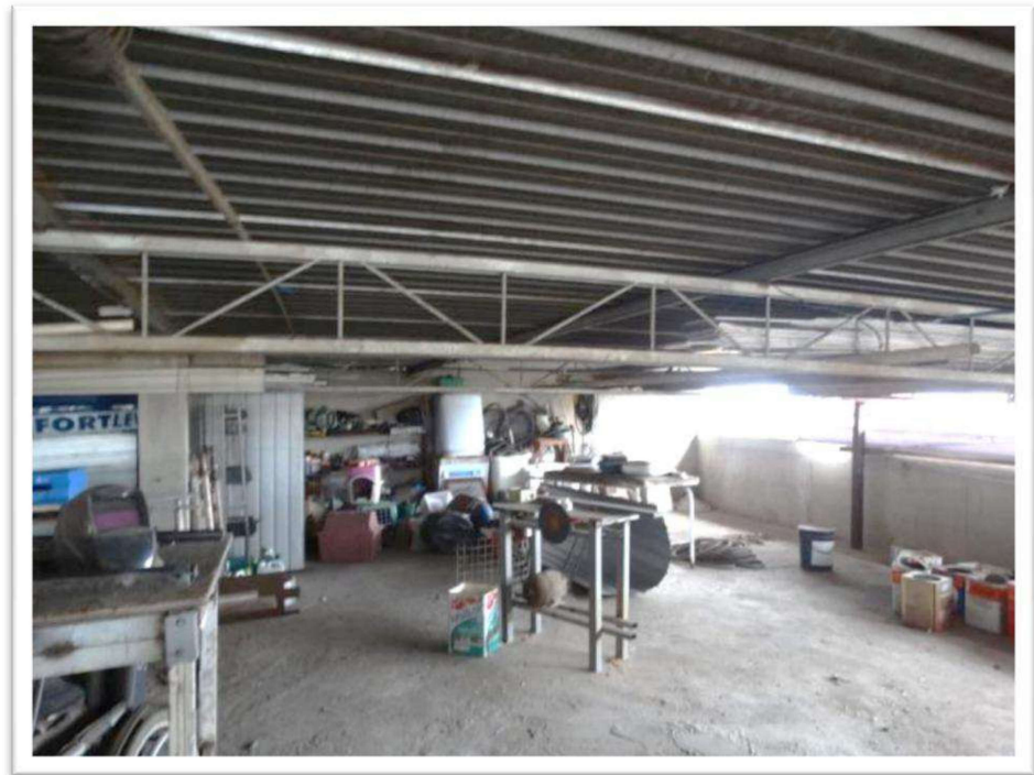
Foto nº 44. Vista parcial interna do imóvel objeto da vistoria – Terraço coberto.
