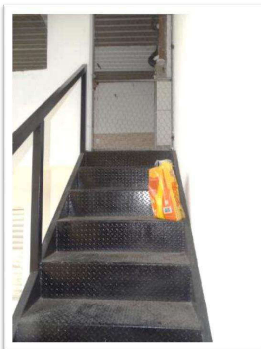
Foto nº 40. Vista parcial interna do imóvel objeto da vistoria – Escada de acesso ao terraço coberto.
