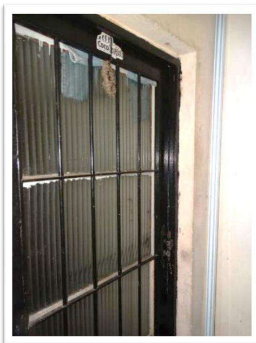
Foto nº 28. Vista parcial interna do imóvel objeto da vistoria – Porta de acesso à residência do 2º pavimento.
