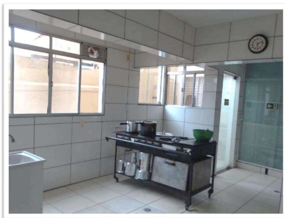
Foto nº 23. Vista parcial interna do imóvel localizado na Rua Raimundo Lúlio, 551 – Objeto da presente vistoria.
