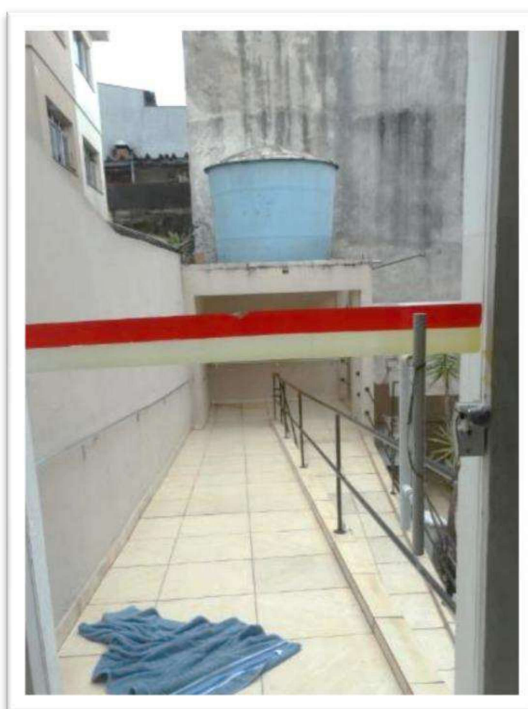
Foto nº 39. Vista parcial interna do imóvel localizado na Rua Raimundo Lúlio, 551 – Objeto da presente vistoria.
