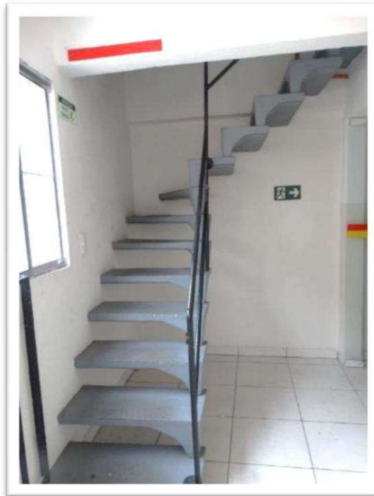
Foto nº 40. Vista parcial interna do imóvel localizado na Rua Raimundo Lúlio, 551 – Objeto da presente vistoria.
