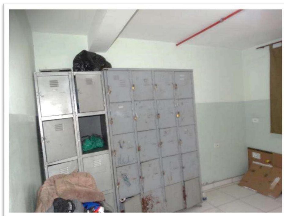
Foto nº 9. Vista parcial interna do imóvel localizado na Rua Raimundo Lúlio, 551 – Objeto da presente vistoria.
