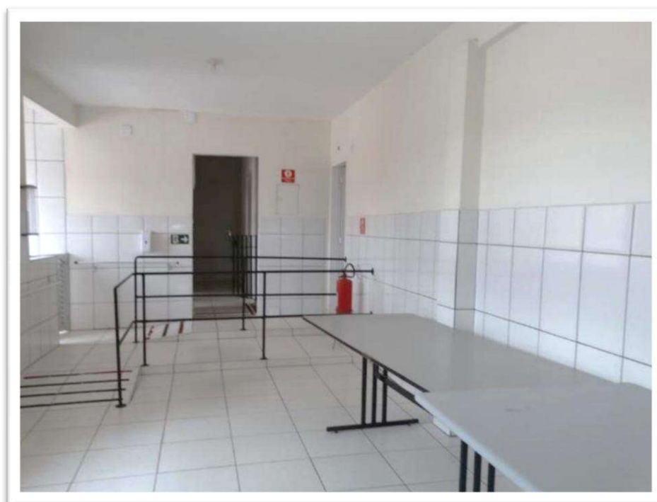
Foto nº 33. Vista parcial interna do imóvel localizado na Rua Raimundo Lúlio, 551 – Objeto da presente vistoria.
