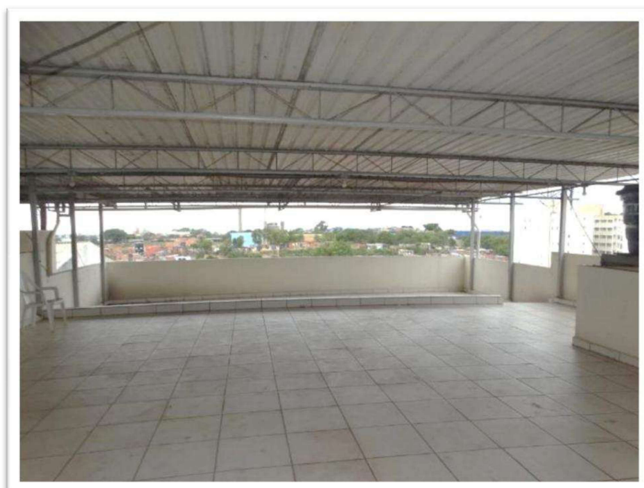
Foto nº 47. Vista parcial interna do imóvel localizado na Rua Raimundo Lúlio, 551 – Objeto da presente vistoria.
