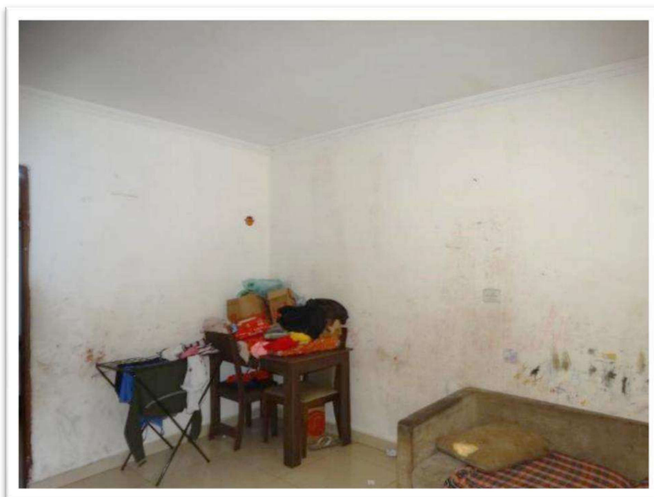
Foto nº 18. Vista parcial interna do imóvel objeto da vistoria – Residência do 1º pavimento.
