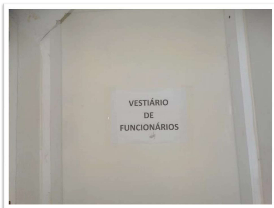
Foto nº 8. Vista parcial interna do imóvel localizado na Rua Raimundo Lúlio, 551 – Objeto da presente vistoria.
