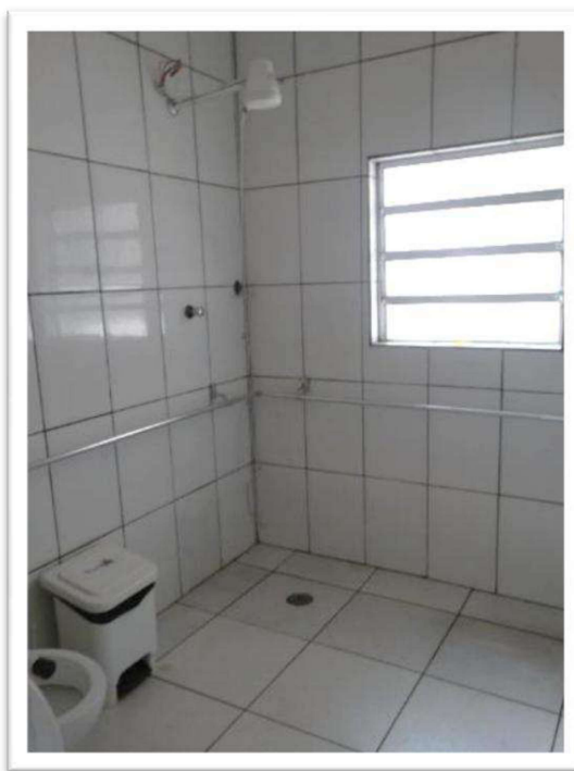
Foto nº 32. Vista parcial interna do imóvel localizado na Rua Raimundo Lúlio, 551 – Objeto da presente vistoria.
