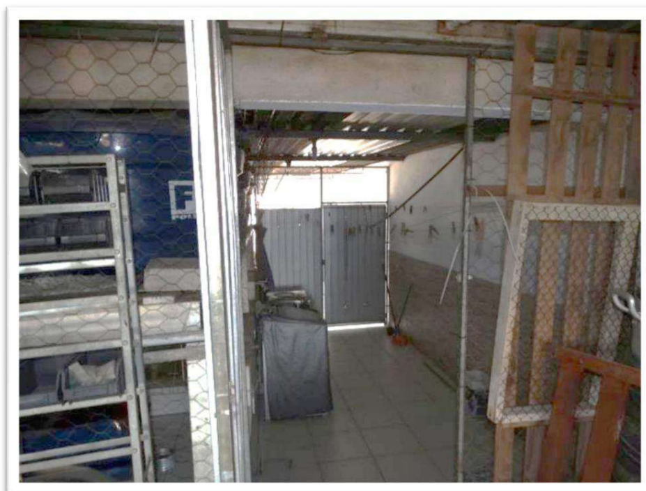
Foto nº 42. Vista parcial interna do imóvel objeto da vistoria – Terraço coberto.
