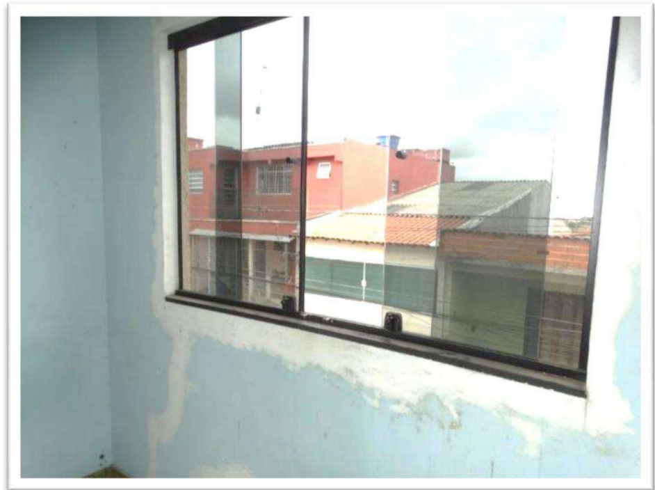
Foto nº 38. Vista parcial interna do imóvel objeto da vistoria – Residência do 2º pavimento.
