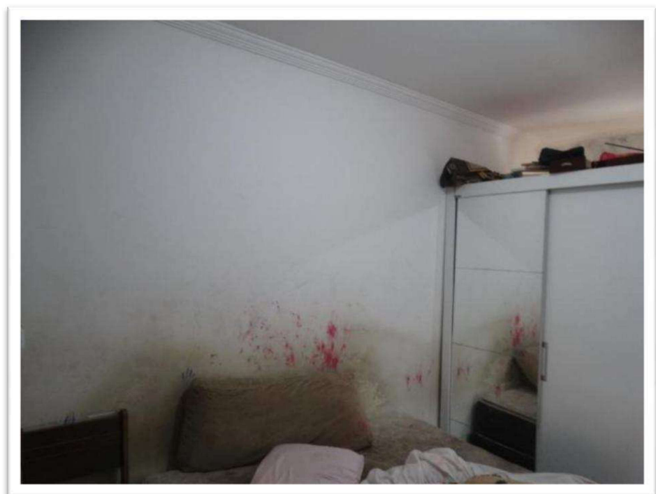
Foto nº 15. Vista parcial interna do imóvel objeto da vistoria – Residência do 1º pavimento.
