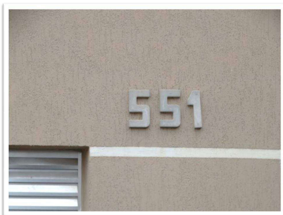
Foto nº 2. Vista do número oficial do imóvel localizado na Rua Raimundo Lúlio, 551 – Jardim São Nicolau – Distrito de São Miguel Paulista – São Paulo-SP., objeto da presente vistoria.
