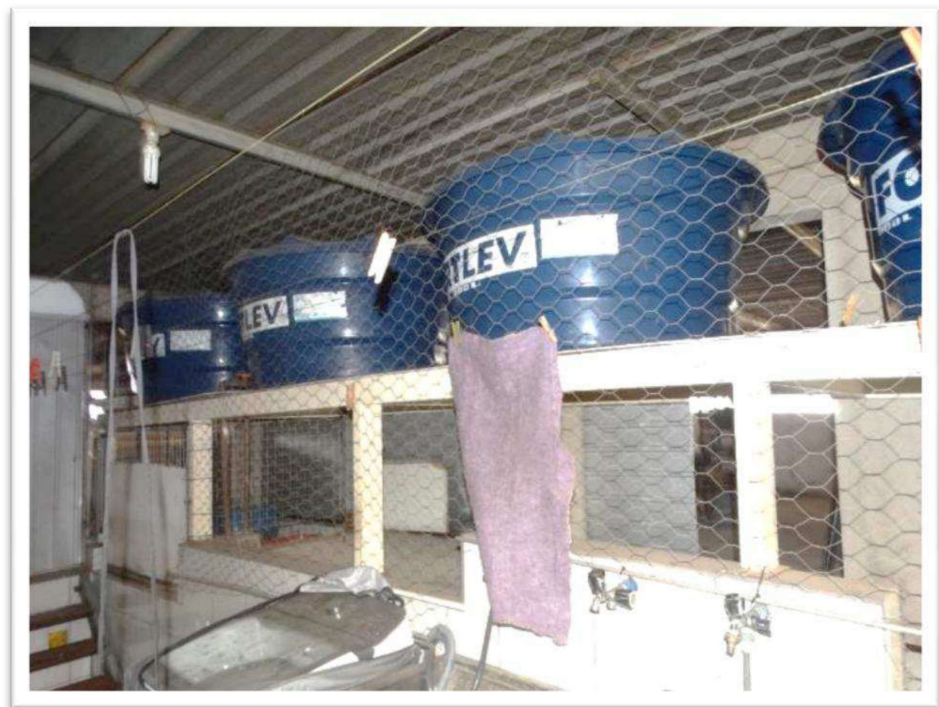
Foto nº 45. Vista parcial interna do imóvel objeto da vistoria – Terraço coberto.
