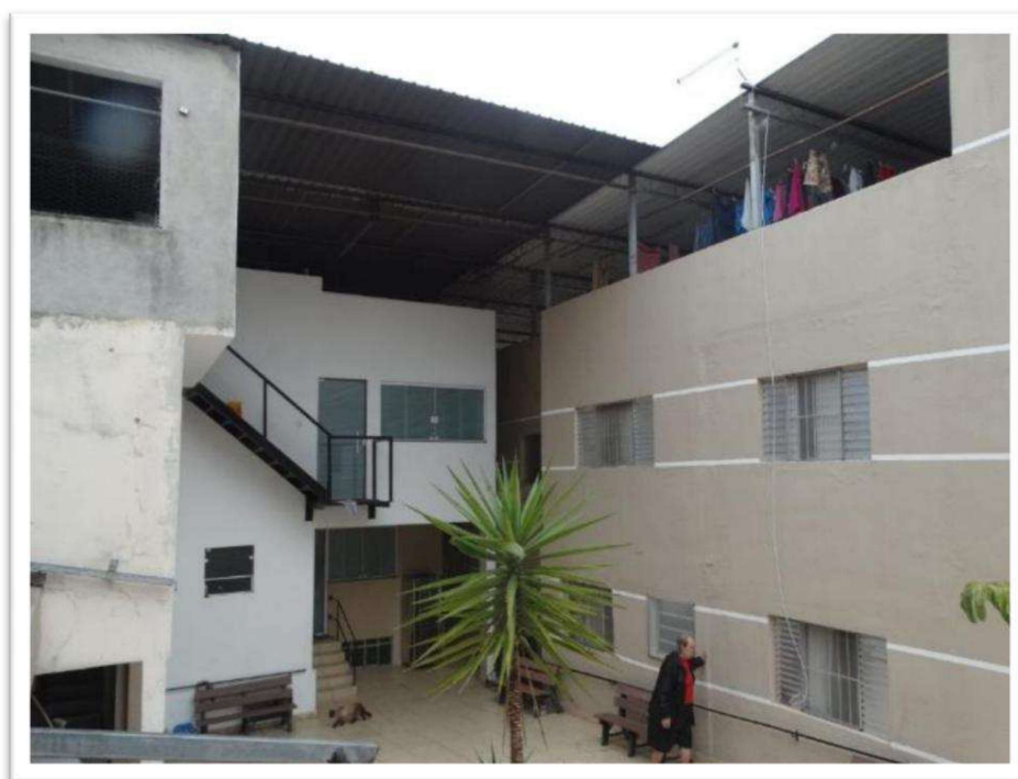
Foto nº 13. Vista do pátio entre os imóveis sob matrículas nº 65.578 (à esquerda) e matrícula nº 171.748 (casa de repouso) à direita da imagem.
