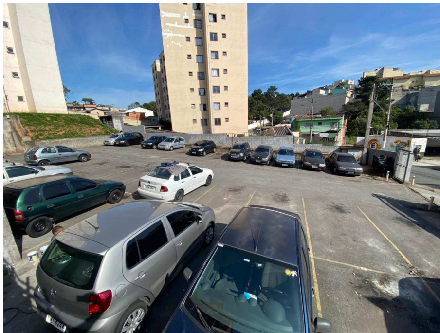
VISTA DO ESTACIONAMENTO DO CONDOMÍNIO.
