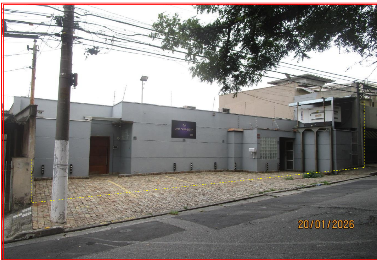
Foto nº 01: Vista geral da fachada do imóvel avaliando.
