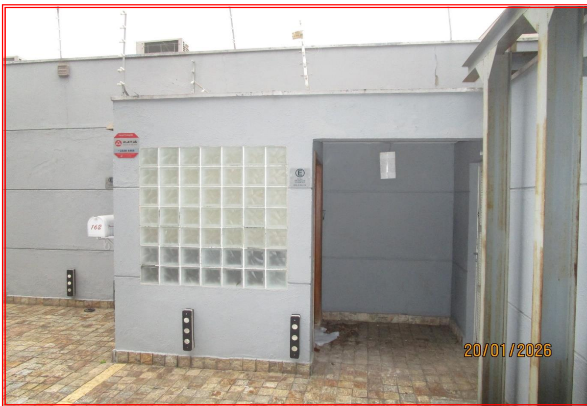
Foto nº 07: Vista da entrada com numeração oficial 162.
