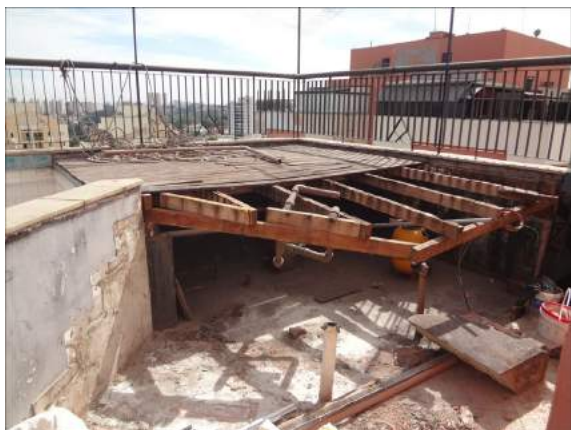
FOTO 91- Deck no Terraço do 19º pav., apartamento 184 – Bloco A, vistoriado por este signatário.
