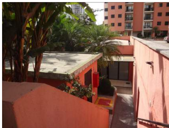
FOTO 37- Escada de acesso: Sala do Gerador a esquerda, Academia ao fundo e Salão de Jogos Infanto Juvenil a direita.
