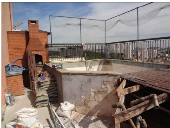
FOTO 89- Churrasqueira, Piscina e Deck no Terraço do 19º pav., apartamento 184 – Bloco A, vistoriado por este signatário.
