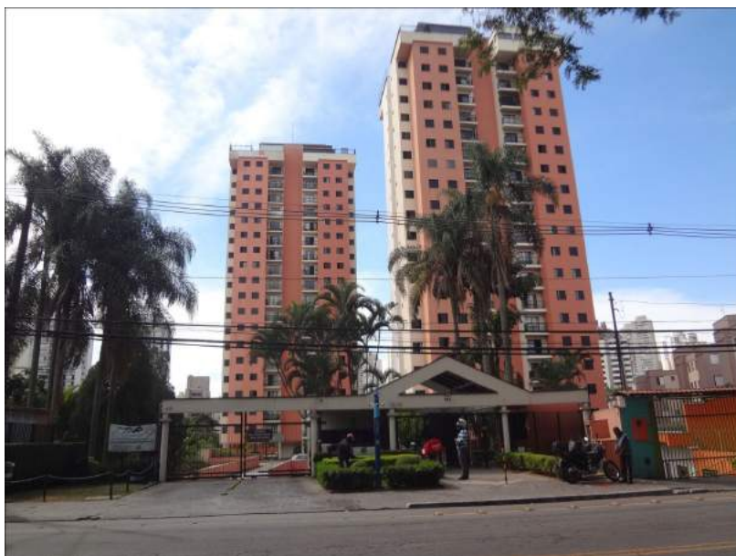
Vista da Portaria do Condomínio Riviera Italiana.
