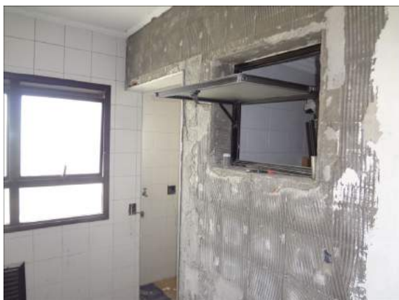
FOTO 67- Área de Serviço e WC, apartamento 184 – Bloco A, vistoriado por este signatário.
