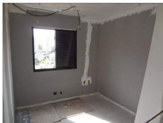
FOTO 76- Dormitório 2, apartamento 184 – Bloco A, vistoriado por este signatário.
