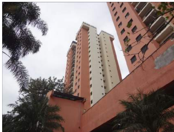
FOTO 8- Vista do Bloco C.
