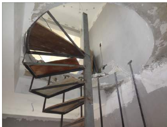
FOTO 80- Escada de acesso ao 19º pav, apartamento 184 – Bloco A, vistoriado por este signatário.
