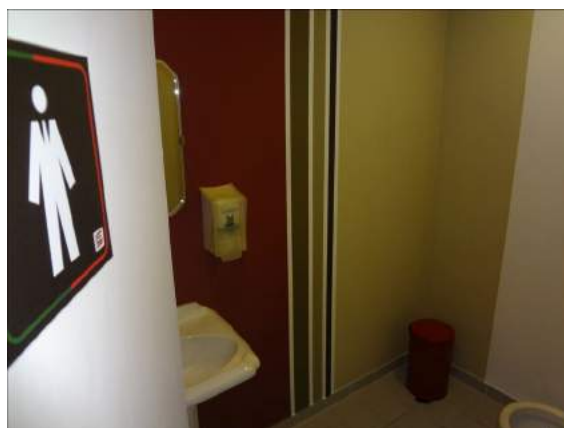
FOTO 23- Sanitário Masculino do Salão de Festas, Bloco A.
