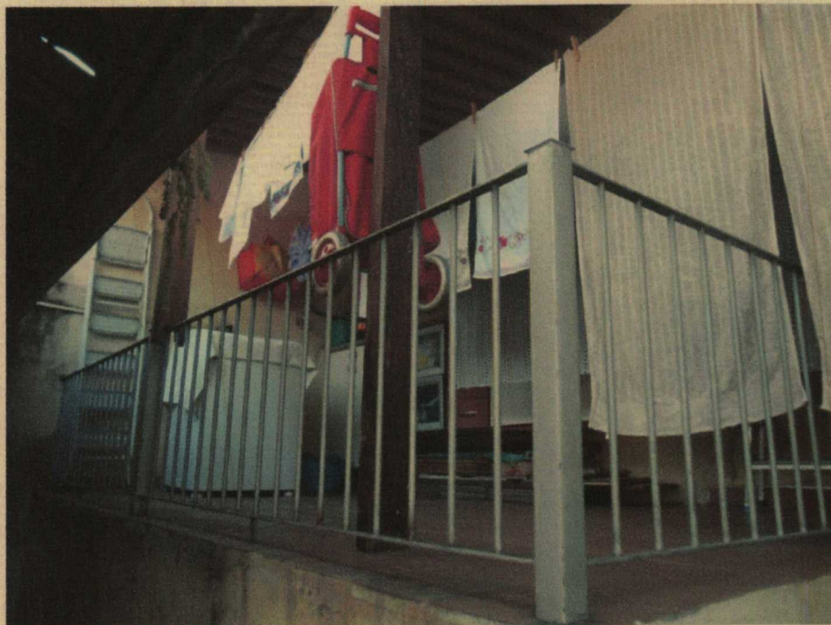
VISTA DA ÁREA DE SERVIÇO COBERTA.
