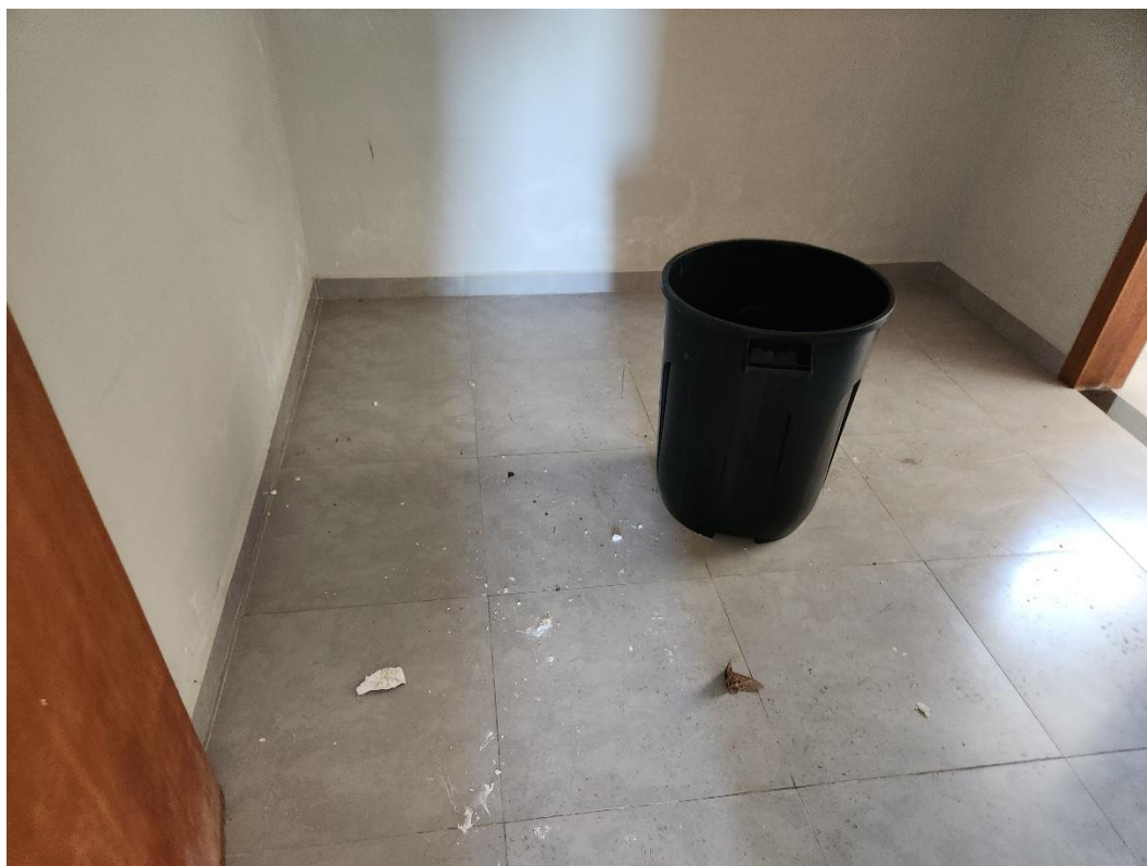
Revestimento do piso da suíte.
