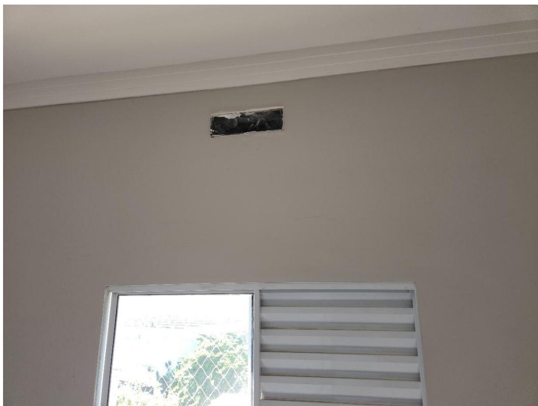
Caixa para instalação de ar-condicionado acima do caixilho.
