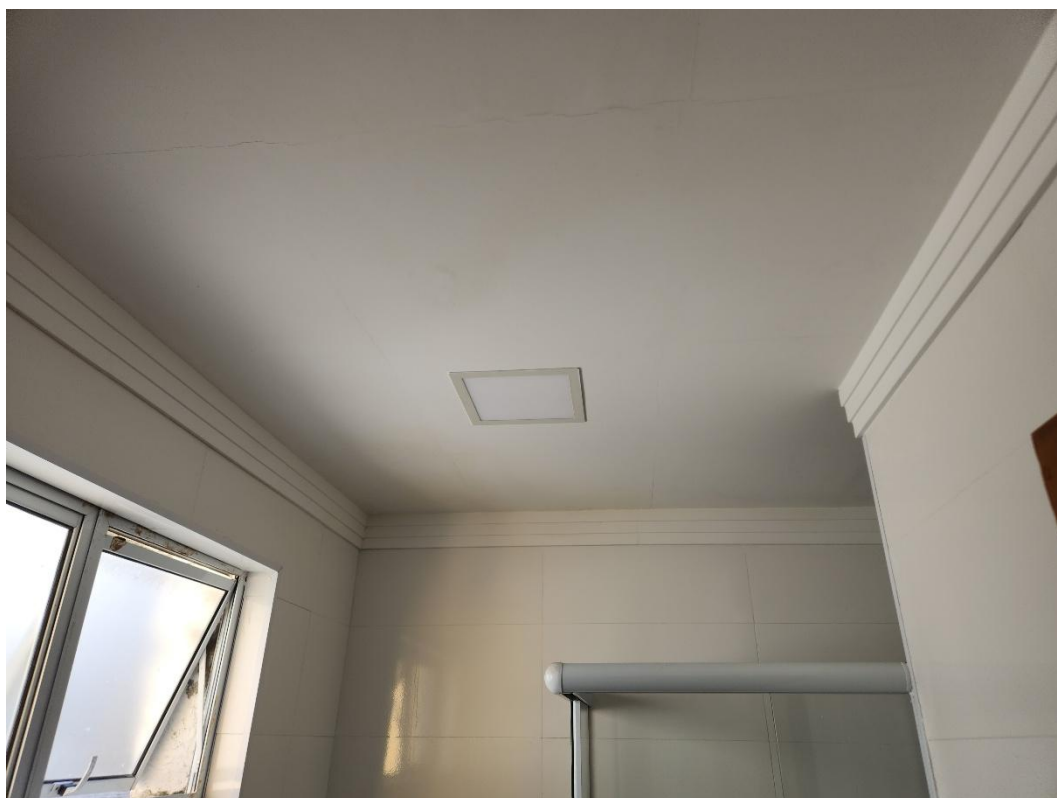
Forro de gesso com iluminação embutida.
