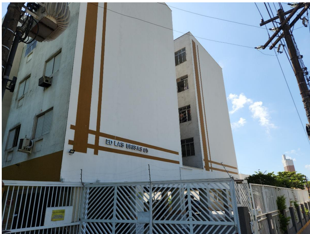
Fachada do Condomínio Las Brisas observada a partir do passeio público.
