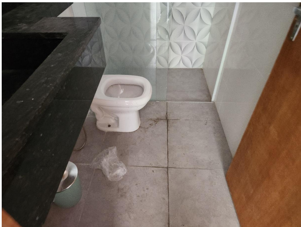
Revestimento do piso do banheiro.
