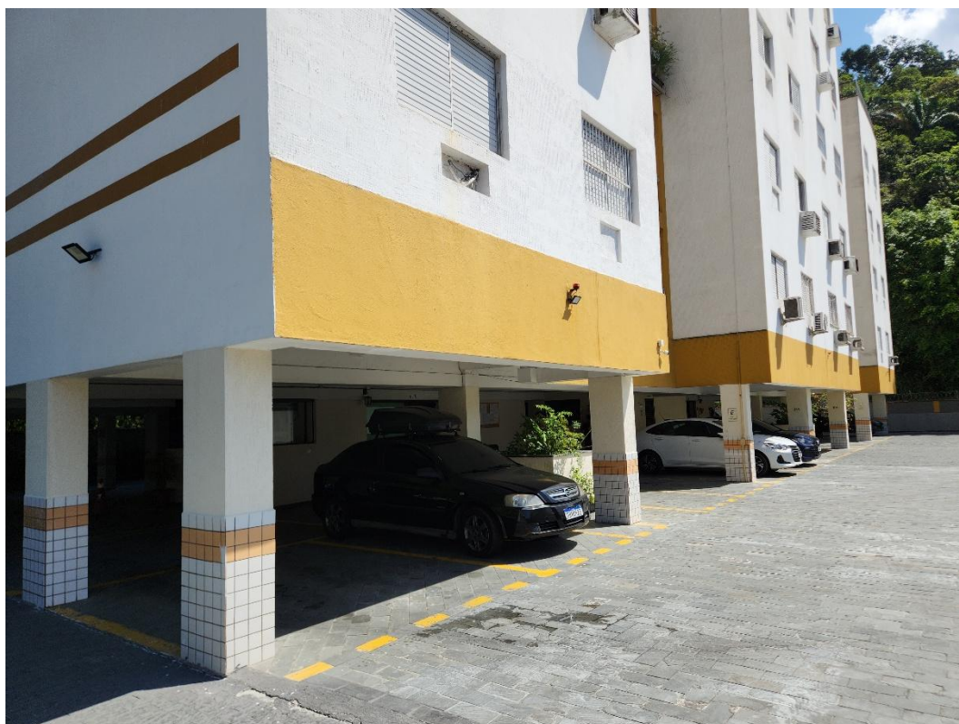
Vagas de estacionamento sob a projeção dos edifícios.
