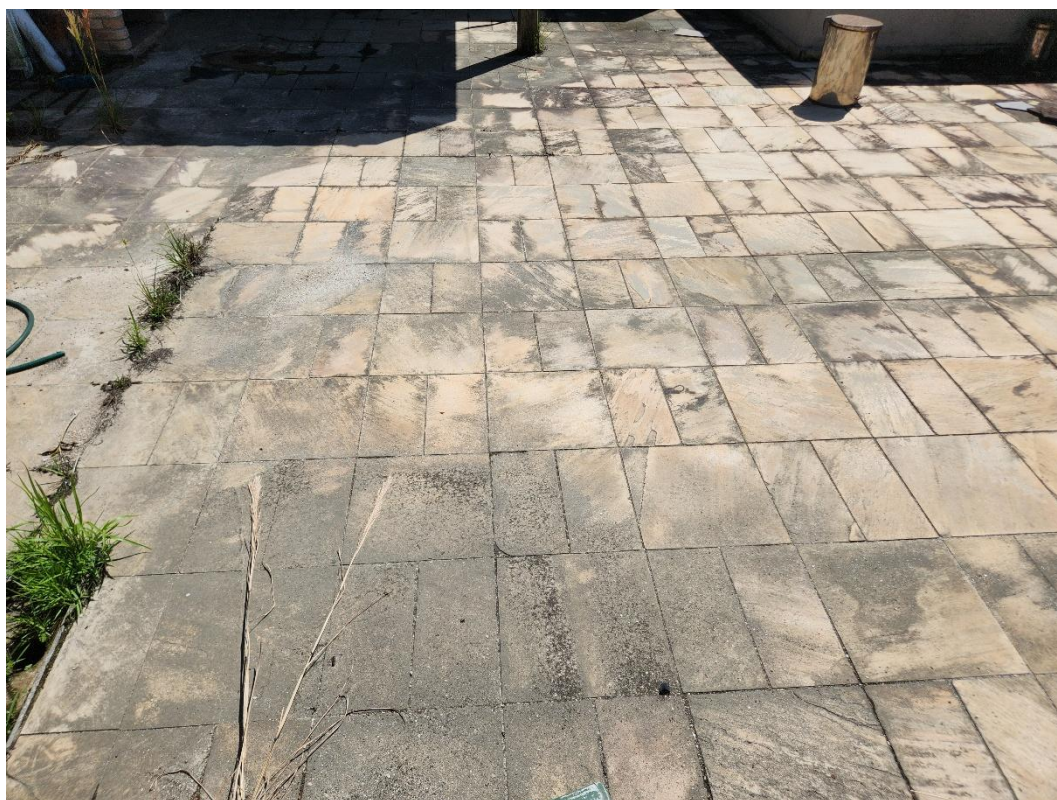
Revestimento cerâmico sobre o piso da área externa.
