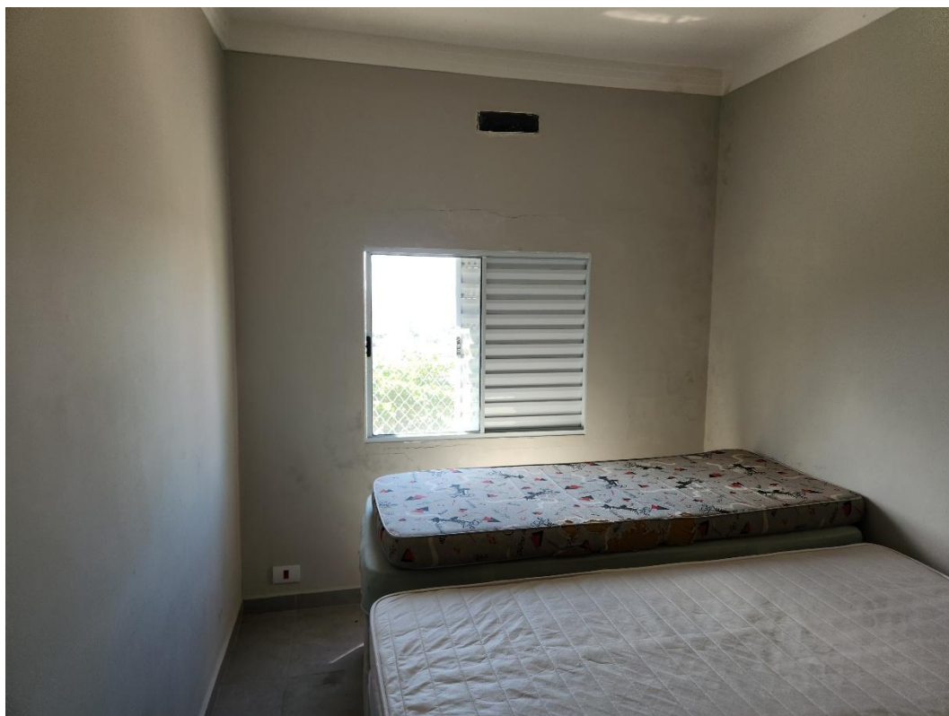
Caixilho do dormitório em alumínio.
