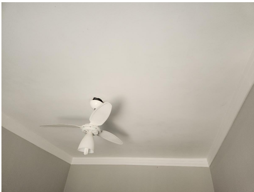
Teto do dormitório com iluminação/ ventilador sobreposto.
