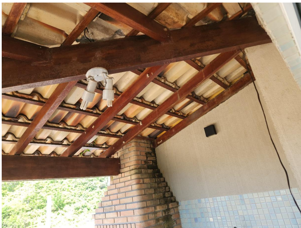
Cobertura da área da churrasqueira em telhas cerâmicas sobre estrutura de madeira.
