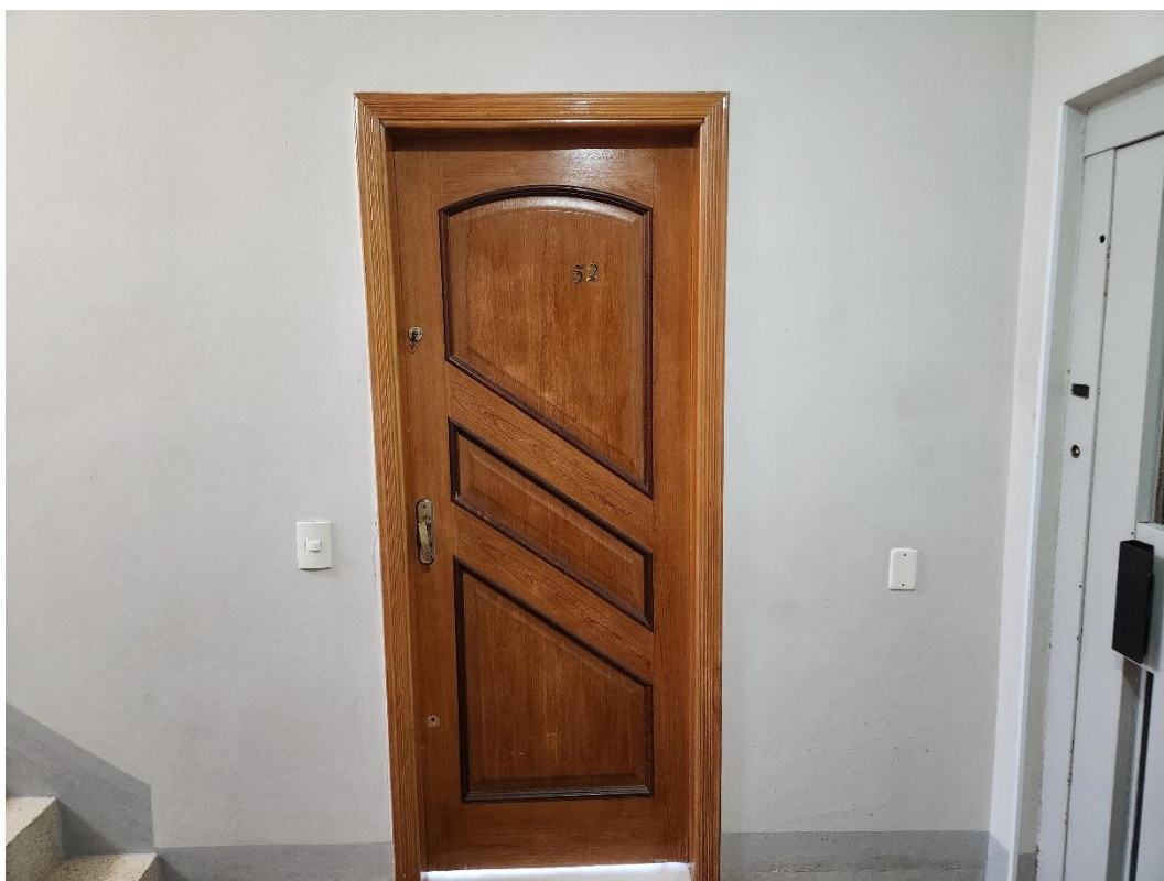
Porta de entrada do apartamento avaliando – unidade nº 52-A.
