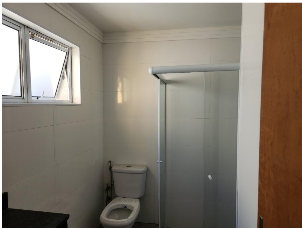
Revestimento cerâmico das demais paredes do banheiro da suíte.
