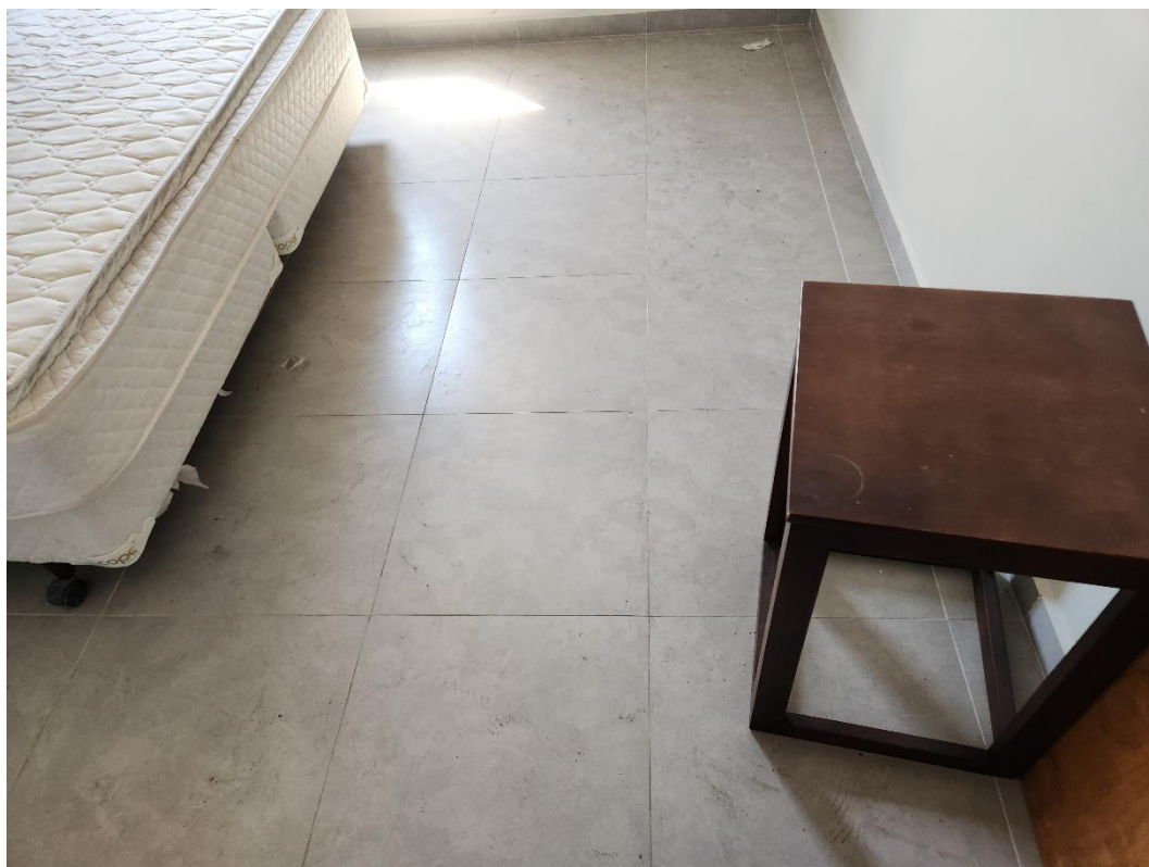
Revestimento cerâmico sobre o piso do segundo dormitório.
