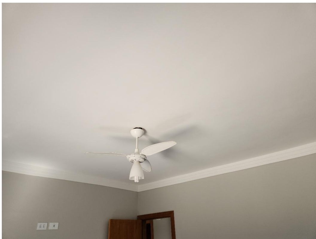
Teto com iluminação/ ventilador sobreposto.
