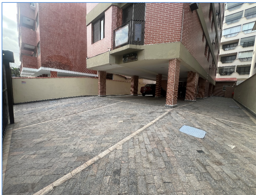
Foto 7 – Pavimento térreo e garagem do edifício
