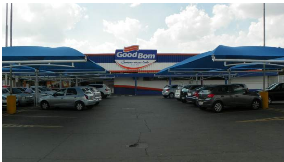
Vista parcial do estacionamento
